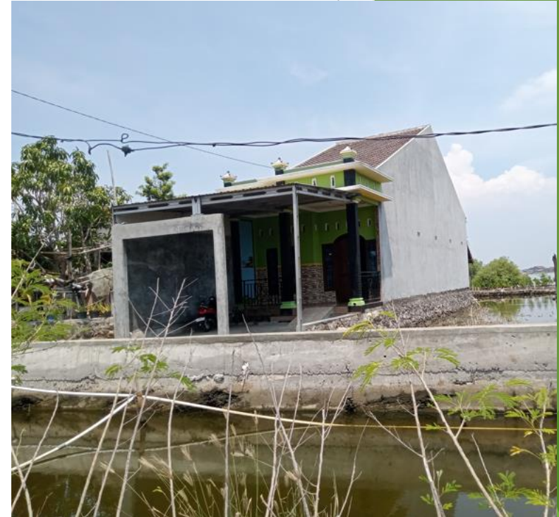
Gambar 3: Rumah baru dengan peninggian lantai rumah untuk mengatasi kondisi rob.
