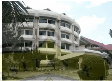
Gambar 1.3 Keruntuhan Akibat Ketidakberaturan Tingkat Lunak Pasca Gempa Asia Tenggara 2004 (Sumber: Ghobarah, dkk., 2006)
