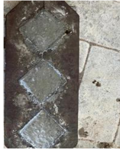
Gambar E.17 Permukaan Mortar Diratakan
