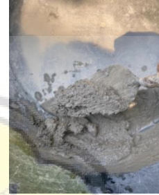
Gambar 4.10 Pengadukan Mortar
