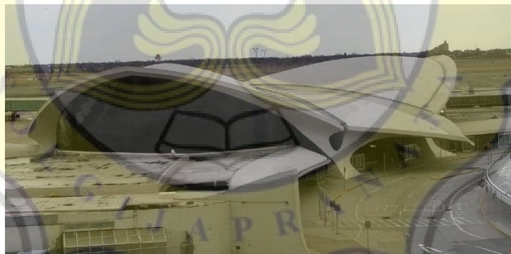
Gambar 3.43 Struktur shell pada TWA Flight Center (Sumber:
