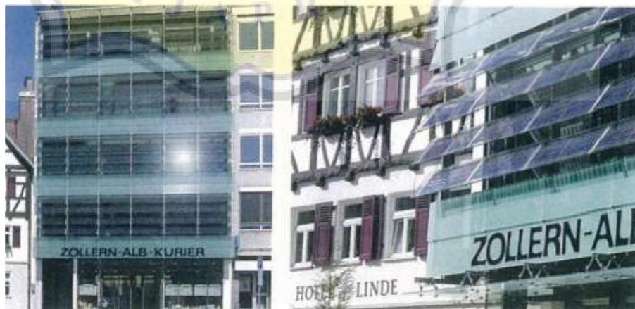
Gambar 30 – Penerapan PV pada Sun Shading
