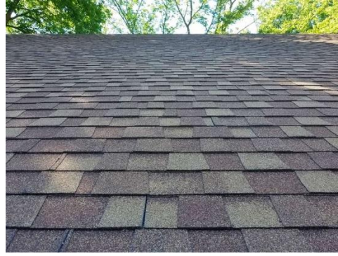
Gambar 112. Penutup Atap Bitumen
