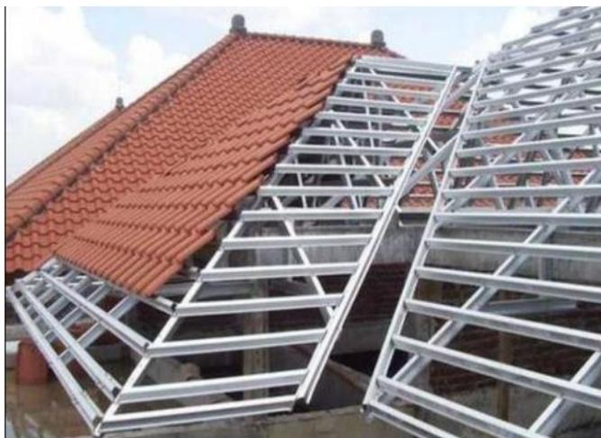
**Gambar VII.29 Genteng Tanah Liat pada Rangka Baja Ringan**
