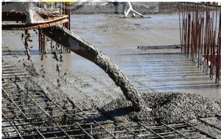
**Gambar VII.31 Proses Pengecoran Dak Beton**
