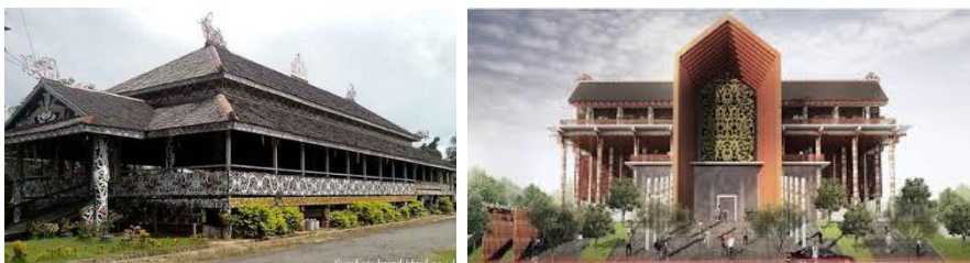
Gambar 85. Gambaran Bentuk Bangunan
