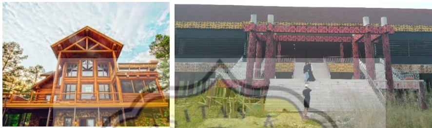
Gambar 74. Bangunan Menghadap Matahari Terbit
