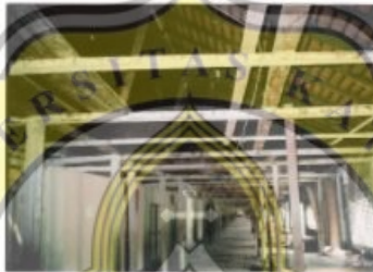
Gambar 35. Bentuk Tiang Serambi sebagai Penyangga untuk para-para atau Plafon
