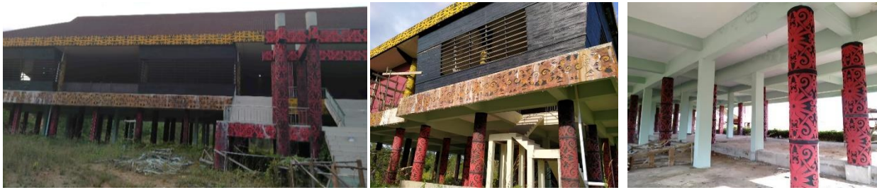
Gambar 63. Pembagian Ruang Pada Rumah Betang di Sintang, Kalimantan Barat
