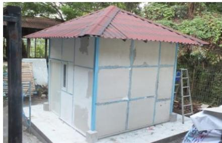
Gambar 4. **Bangunan contoh dengan dinding *Perva – GRC Sandwich Wall Panel***
