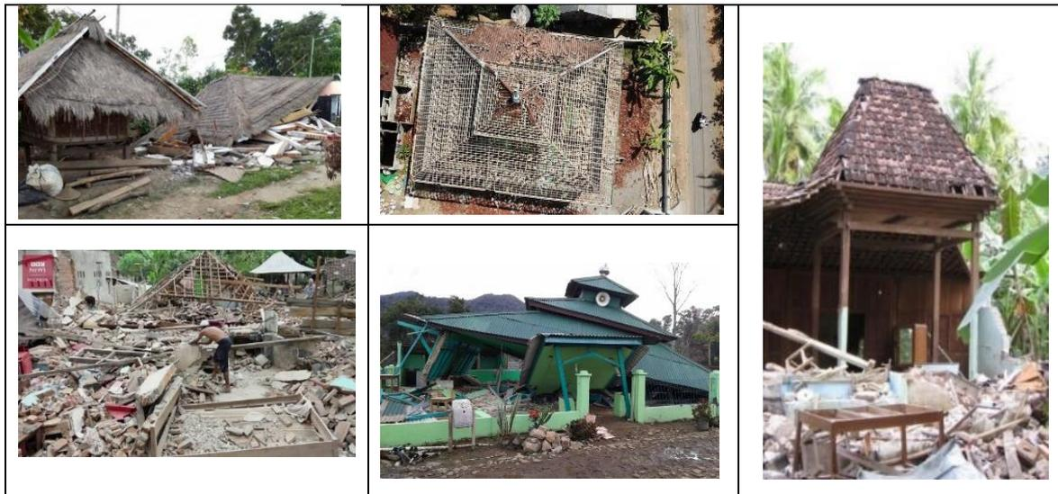
Gambar 2. Kasus-kasus gempa bumi di sejumlah daerah yang menyebutkan kalau konstruksi atap tetap bertahan utuh, namun karena kedua tumpuannya berbentuk empak sudut maka saat terjadi goyangan atap jatuh roboh ketanah.
