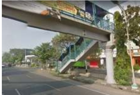
Gambar 3.9 : Jembatan Pejalan Kaki
