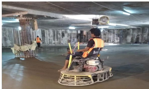
Gambar 3.39. Proses Pekerjaan Finishing dengan Alat Trowel Finish
