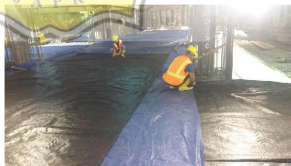
Gambar 3.71. Susunan Lapis untuk Curing Sumber: Dokumentasi Pribadi, 2019
