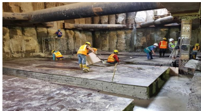
Gambar 3.32. Pemasangan Lantai Plywood Sumber: Arsip PT. Total Bangun Persada
