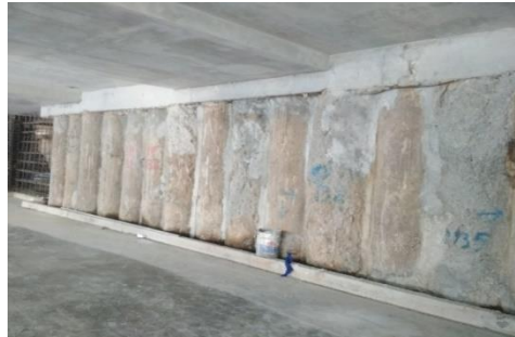
Gambar 3.17. Secant Pile Sumber: Dokumentasi Pribadi, 2019
