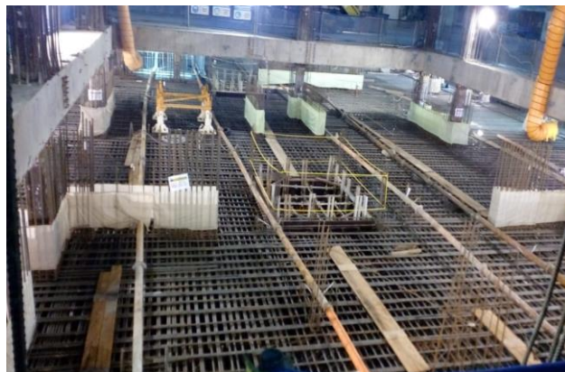
Gambar 3.60. Area Matt Foundation Siap Cor Sumber: Dokumentasi Pribadi, 2019
