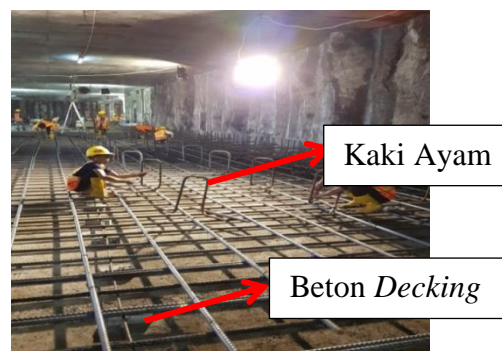
Gambar 3.35. Pembesian Pelat Lantai Basement 3 Sumber: Dokumentasi Pribadi, 2019
