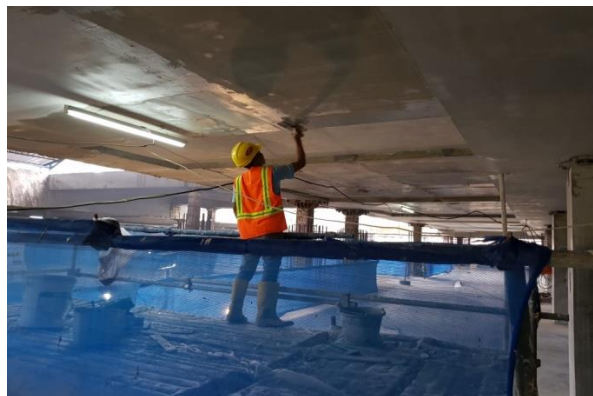
Gambar 3.41. Proses Skim Coating Sumber: Dokumentasi Pribadi, 2019
