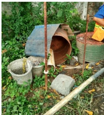
Gambar 3.104. Sumur Bor yang Ditutup Sumber: Dokumentasi Pribadi, 2019
