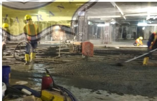
Gambar 3.38. Proses Pengecoran Area Basement 3 Sumber: Dokumentasi Pribadi, 2019
