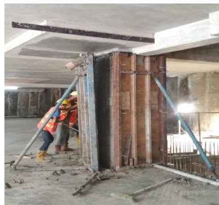
Gambar 3.51a. Proses Pelepasan Bekisting Sumber: Dokumentasi Pribadi, 2019
