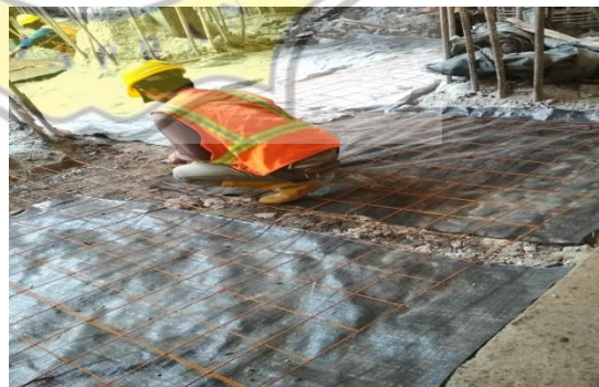
Gambar 3.53. Pemasangan geotextil dan wiremesh Sumber: Dokumentasi Pribadi, 2019
