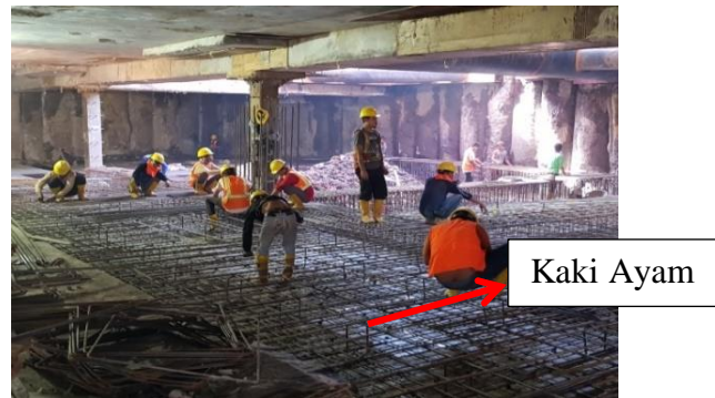
Gambar 3.34. Pembesian Pelat Lantai Basement 2 Sumber: Arsip PT. Total Bangun Persada
