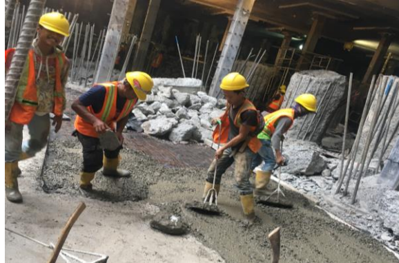
Gambar 3.31. Proses Pengecoran Lantai Kerja Sumber: Dokumentasi Pribadi, 2019
