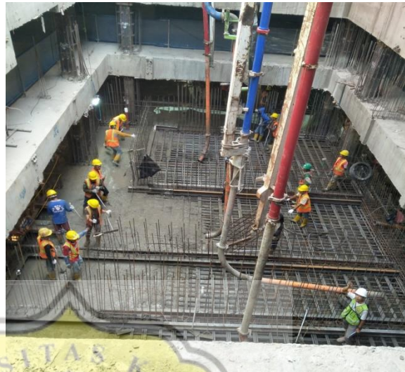
Gambar 3.63a. Proses Pengecoran Matt Foundation Sumber: Dokumentasi Pribadi, 2019
