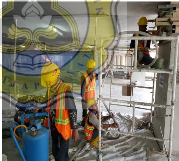
Gambar 3.51b. Proses Grouting Kepala Kolom Sumber: Dokumentasi Pribadi, 2019
