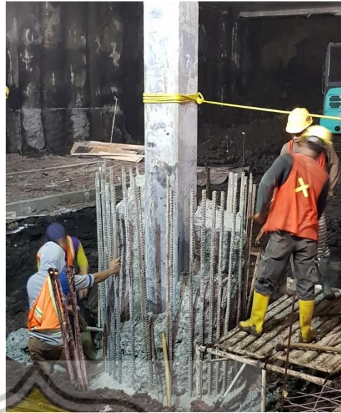
Gambar 3.43. Proses Bobok Bore Pile Sumber: Dokumentasi Pribadi, 2019
