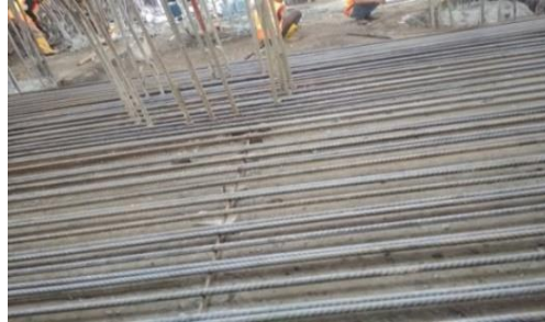
Gambar 3.55. Pemasangan Pembesian Layer Pertama Sumber: Dokumentasi Pribadi, 2019
