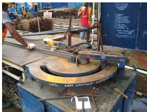
Gambar 3.78. Alat Bar Bender Sumber: Dokumentasi Pribadi, 2019
