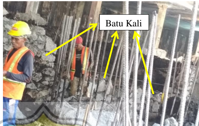
Gambar 3.52. Pemasangan Batu Kali Sumber: Dokumentasi Pribadi, 2019
