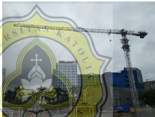
Gambar 3.97. Tower Crane Sumber: Dokumentasi Pribadi, 2019
