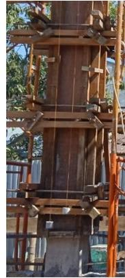
Gambar 3.44 Pengecekan Ketegakan Kolom
