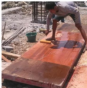
Gambar 3.41 Pelapisan dengan Solar pada Bekisting Kolom
