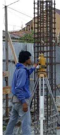
Gambar 3.39 Pengukuran terhadap Letak As dan Bekisting Kolom
