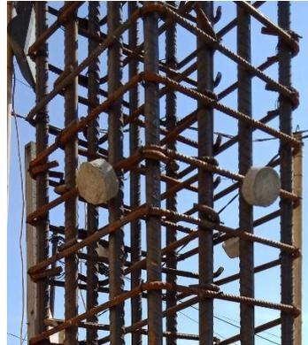
Gambar 4.6 Beton *Decking* pada Kolom
