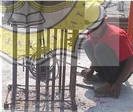
Gambar 4.7 Pengelasan Sepatu Kolom
