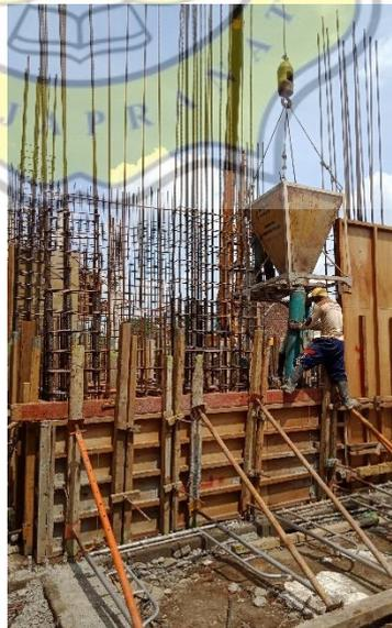
Gambar 3.72 Pengecoran *Shear Wall*
