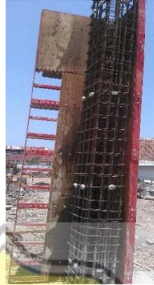
Gambar 3.42 Pemasangan Bekisting Kolom
