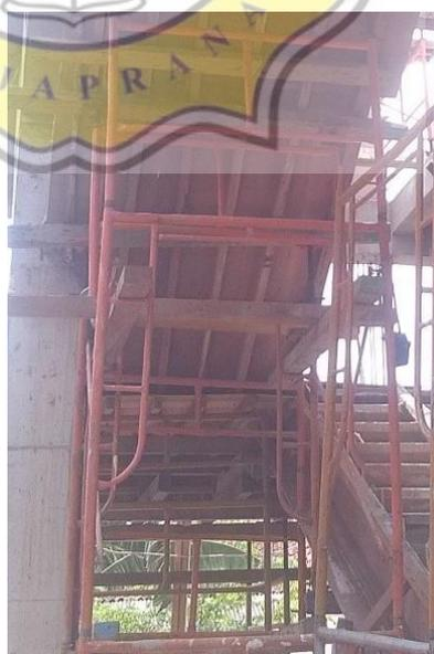
Gambar 3.63 Pemasangan Bekisting dan *Scaffolding*
