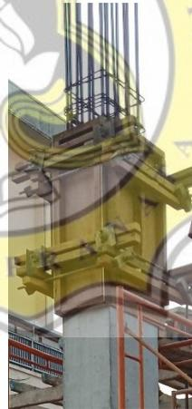
Gambar 3.47 Pemasangan Bekisting Kepala Kolom
