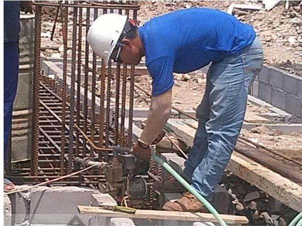
Gambar 3.23 *Dewatering* pada *Pile Cap*
