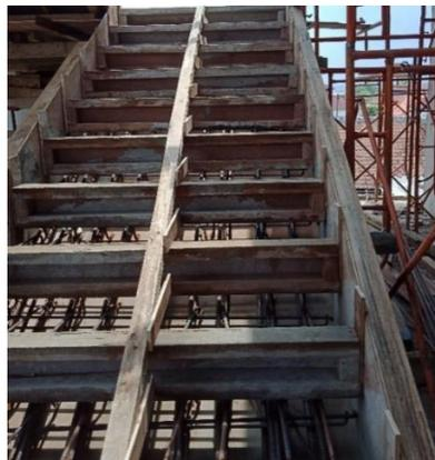
Gambar 3.68 Pemasangan Bekisting Anak Tangga
