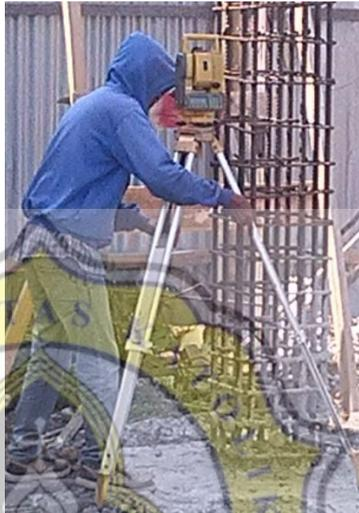
Gambar 4.5 Pengukuran dengan *Theodolite*
