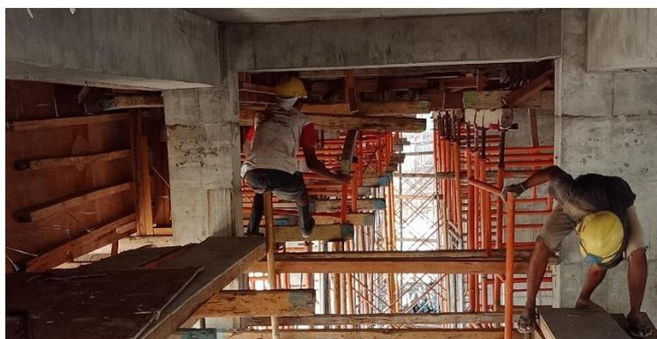
Gambar 4.24 Pembongkaran Bekisting Pelat Lantai dan Balok
