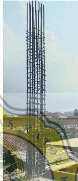
Gambar 4.3 Pemasangan Tulangan Kolom
