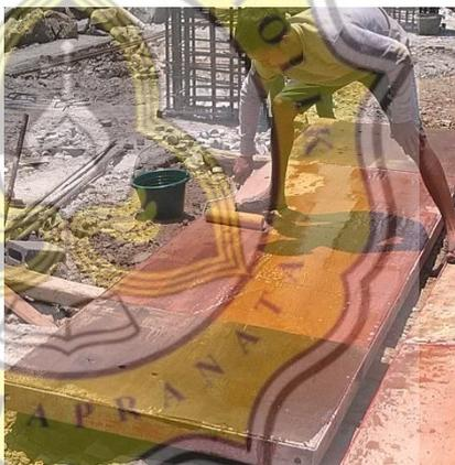
Gambar 4.9 Proses Melapisi Solar ke Bekisting Kolom
