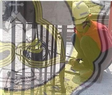
Gambar 3.40 Pengelasan untuk Memasang Sepatu Kolom
