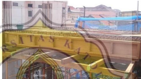
Gambar 3.53 Pemasangan Bekisting Balok Bagian Samping
