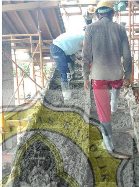
Gambar 3.69 Pengecoran Tangga
