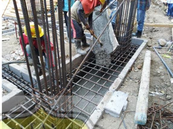
Gambar 3.28 Pengecoran *Pile Cap*
