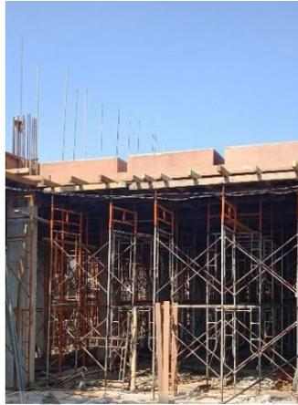
Gambar 3.57 Pemasangan Bekisting Pelat Lantai
