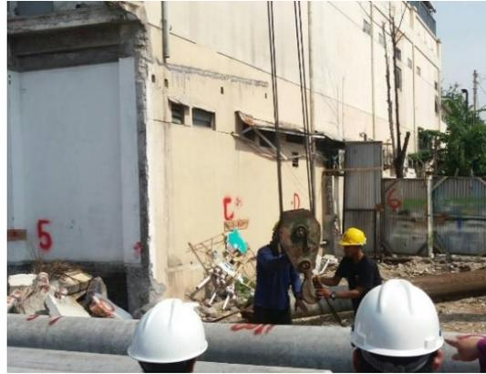
Gambar 3.12 Pengikatan Tiang Pancang Menggunakan *Sling* yang Dibantu oleh Pekerja
