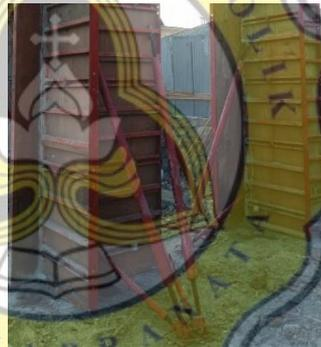
Gambar 3.43 Penahan Bekisting Kolom menggunakan *Pipa Support*
