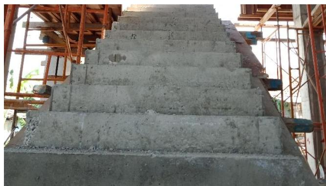
Gambar 4.30 Pelepasan Bekisting Anak Tangga
