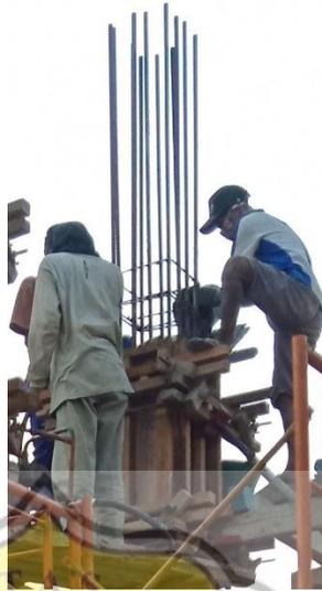
Gambar 3.48 Pengecoran Kepala Kolom
