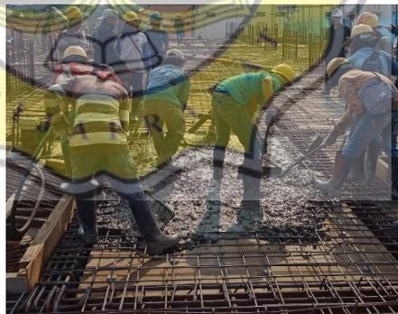
Gambar 3.61 Pengecoran Pelat Lantai
