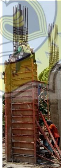
Gambar 3.45 Pengecoran Kolom
