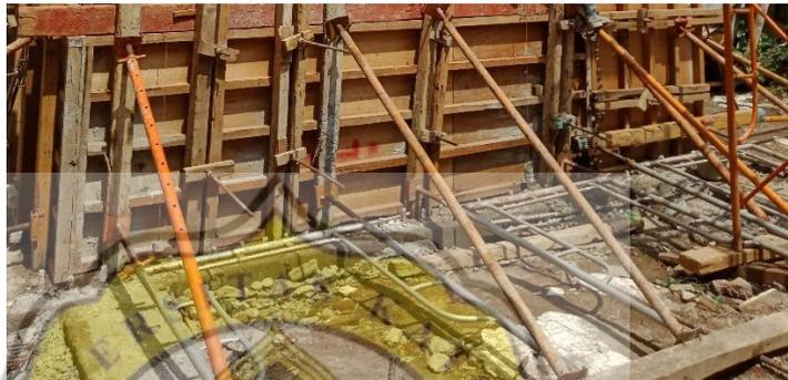
Gambar 3.71 Pemasangan *Tie Rod* dan *Scaffolding*
