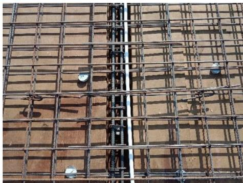
Gambar 3.59 Pemasangan Tahu Beton
