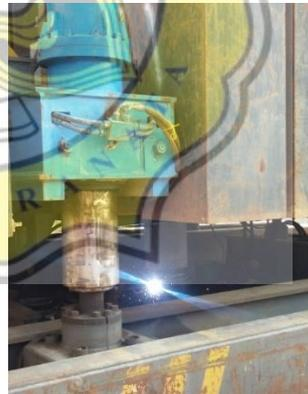
Gambar 3.16 Proses Pengelasan Sambungan Tiang
