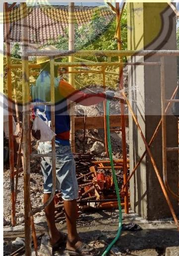
Gambar 3.49 *Curing* untuk Kolom
