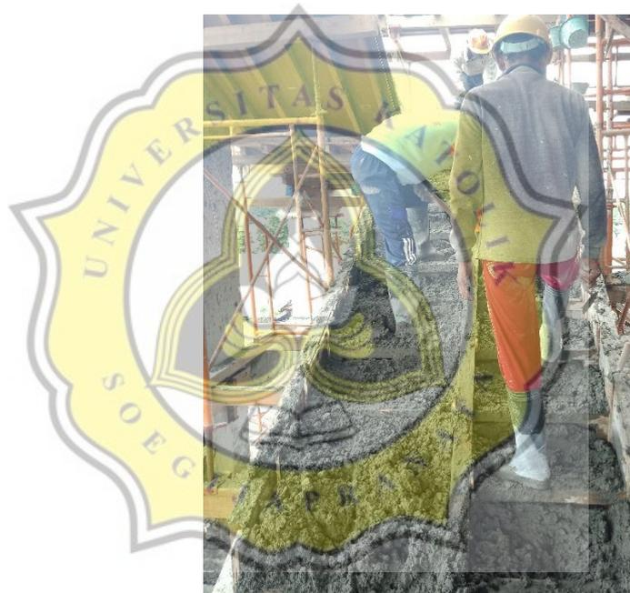
Gambar 4.29 Pengecoran Anak Tangga
