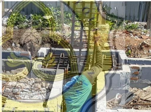
Gambar 3.26 Penulangan *Pile Cap* dan Merangkai Sambungan Kolom
