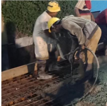
Gambar 3.55 Pengecoran Balok
