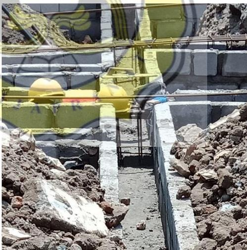
Gambar 3.30 Rabat Beton pada *Tie Beam*
