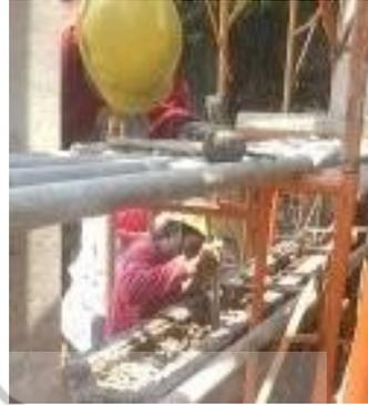
Gambar 3.36 Pengecoran *Sloof*
