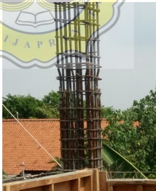
Gambar 4.4 Panjang Penyaluran Tulangan Kolom
