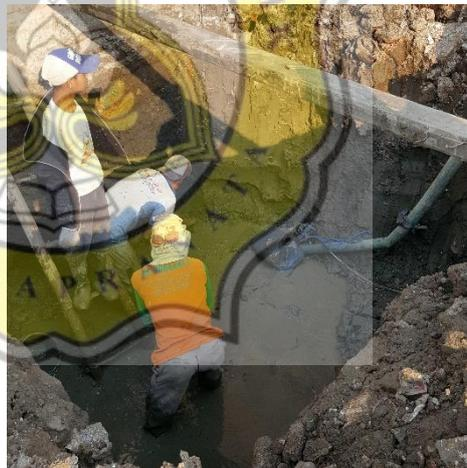
Gambar 3.20 Galian Tanah untuk Pondasi *Foot Plat*
