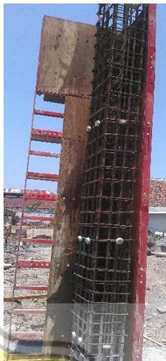
Gambar 4.10 Pemasangan Bekisting Kolom
