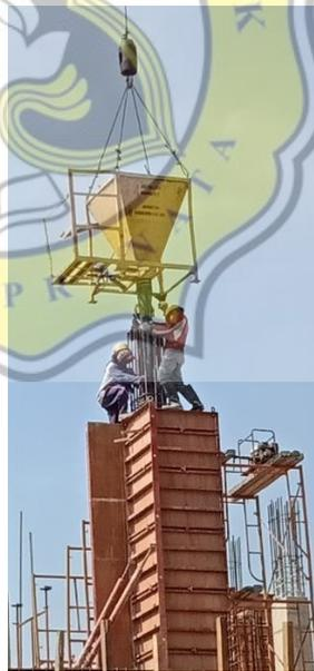
Gambar 4.12 Pengecoran Kolom
