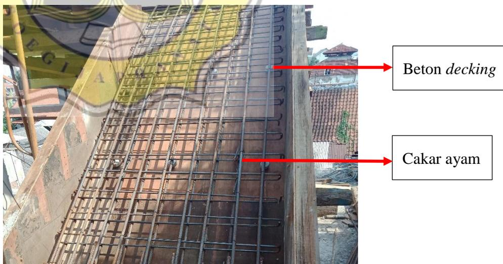
Gambar 4.27 Pemasangan Beton *Decking* dan Cakar Ayam
