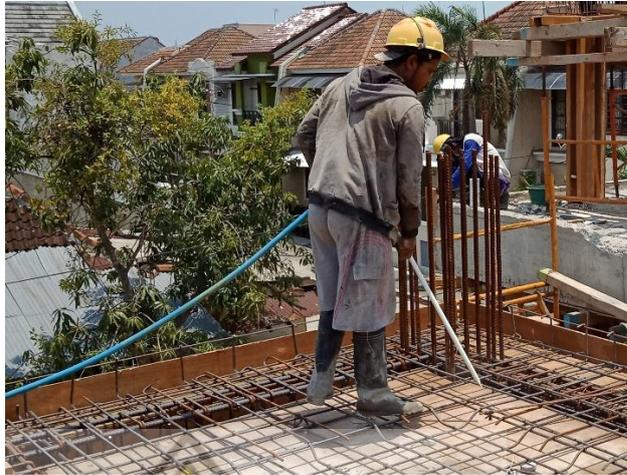
Gambar 4.21 Pembersihan menggunakan *Air Compressor*
