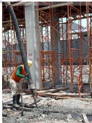
Gambar 3.33 Pengecoran *Tie Beam*
