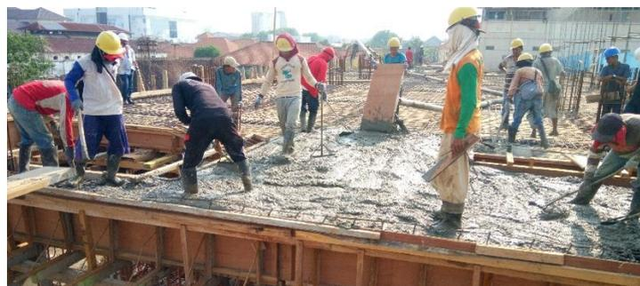
Gambar 4.22 Pengecoran Pelat Lantai dan Balok
