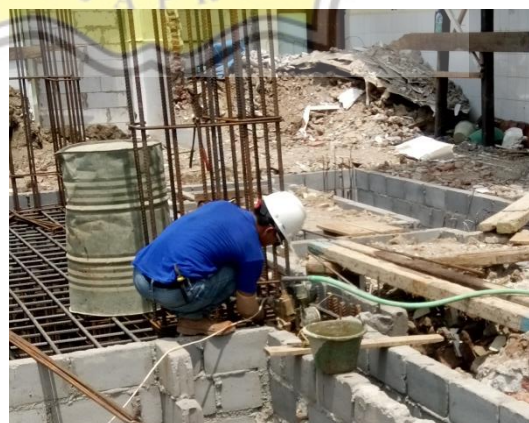
Gambar 3.28 Pekerjaan Dewatering
