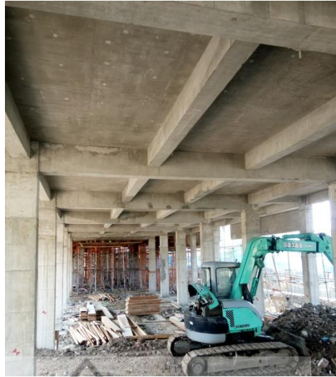
Gambar 3.43 Pelepasan Bekisting Balok dan Pelat Lantai
