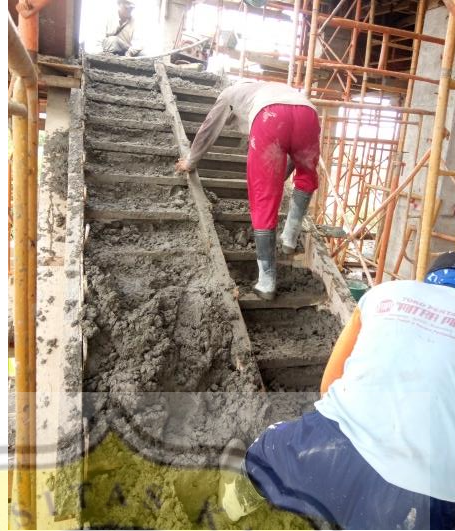
Gambar 3.52 Proses Pengecoran Tangga
