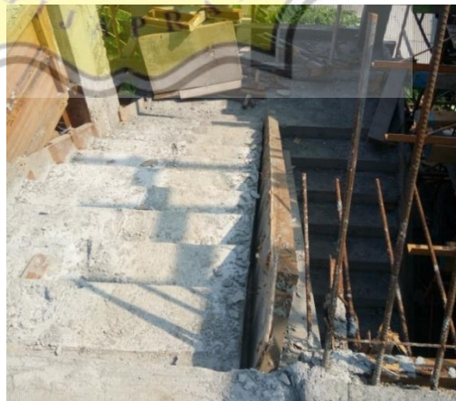
Gambar 3.53 Pelepasan Bekisting Tangga
