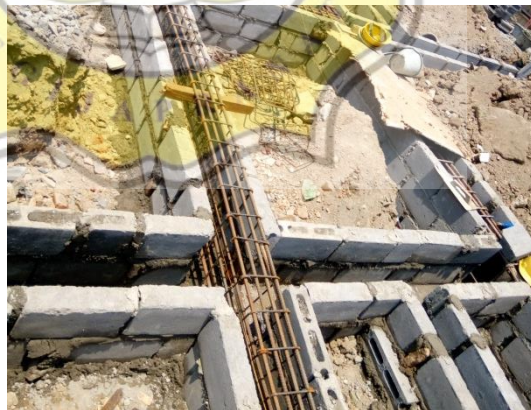
Gambar 3.18 Pemasangan Bekisting Tie Beam
