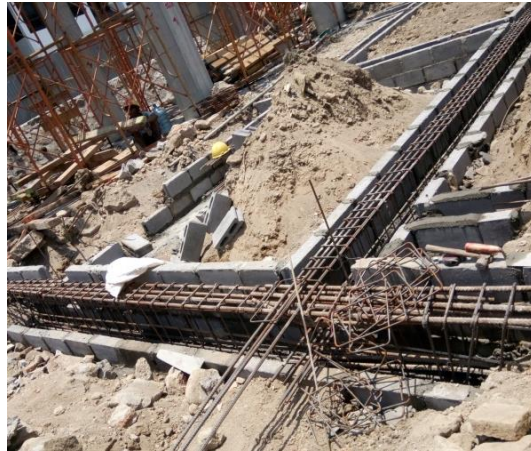
Gambar 3.17 Penulangan Tie Beam
