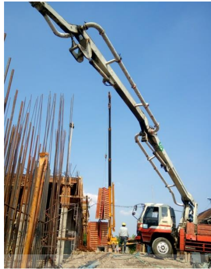
Gambar 3.41 Mengarahkan Pipa Concrete Pump Menuju Lokasi yang Akan Dicor
