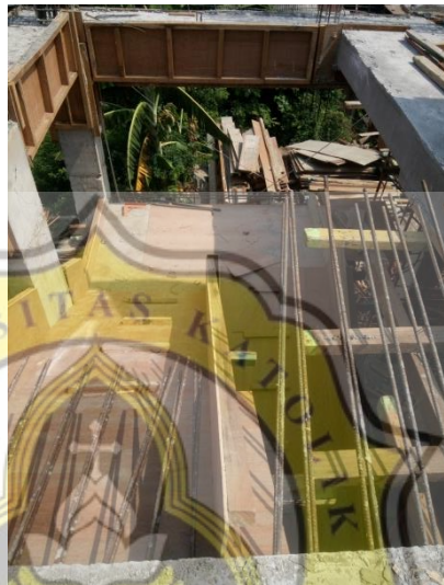
Gambar 3.49 Bekisting Tangga
