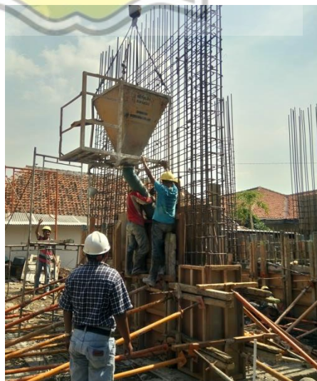
Gambar 3.33 Pengecoran Shear Wall Lantai 1 dengan Tremi
