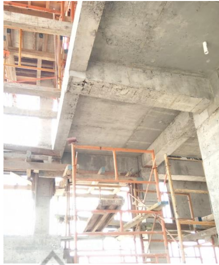
Gambar 3.48 Pelepasan Bekisting Pelat Lantai
