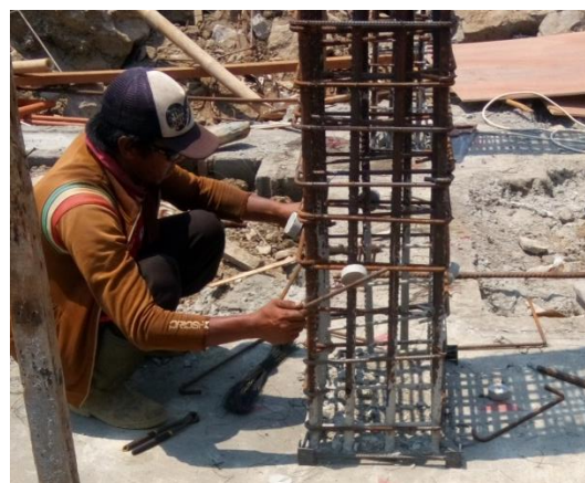
Gambar 3.21 Pemasangan Tahu Beton Pada Tulangan Kolom
