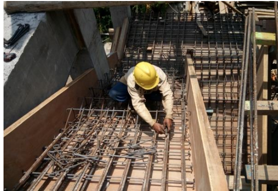
Gambar 3.50 Pekerjaan Penulangan Tangga
