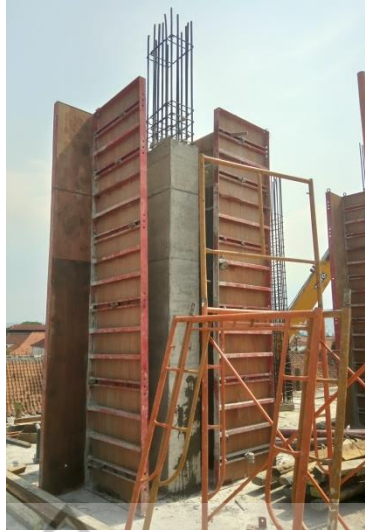
Gambar 3.25 Pelepasan Bekisting Kolom
