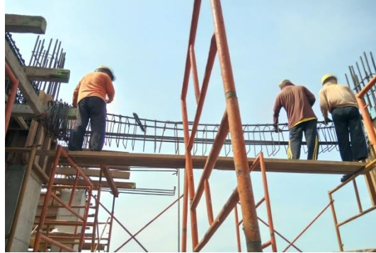
Gambar 3.38 Penulangan Balok
