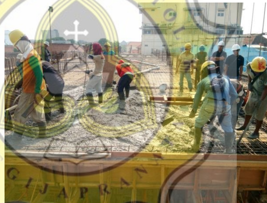
Gambar 3.42 Pengecoran Balok
