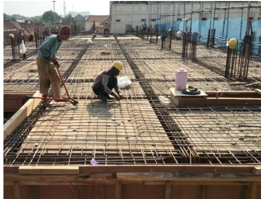
Gambar 3.45 Penulangan Pelat Lantai
