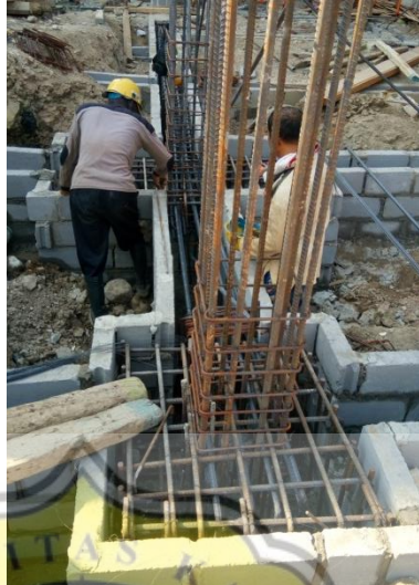
Gambar 3.14 Pemasangan Bekisting Pile Cap
