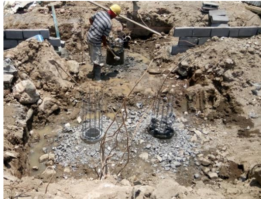
Gambar 3.12 Pemecahan Pondasi Tiang Pancang dengan Palu
