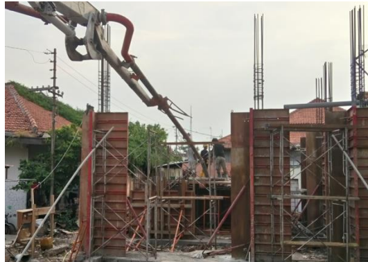
Gambar 3.31 Mengarahkan Concrete Pump ke Shear Wall
