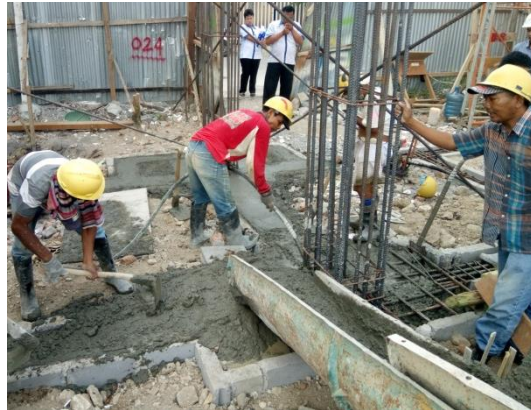
Gambar 3.15 Pengecoran Pile Cap
