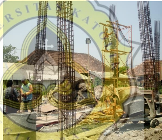
Gambar 3.20 Penulangan Kolom
