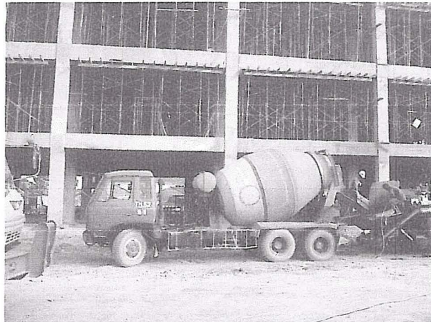
Gambar 4.12 Concrete mixer truck (Sumber: Dokumentasi Pribadi tahun 2010)
