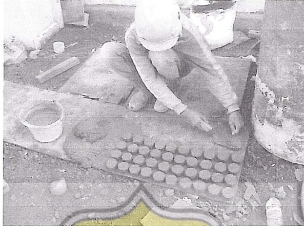
Gambar 4.5 Tahu Beton (Sumber: Dokumentasi Pribadi tahun 2010)
