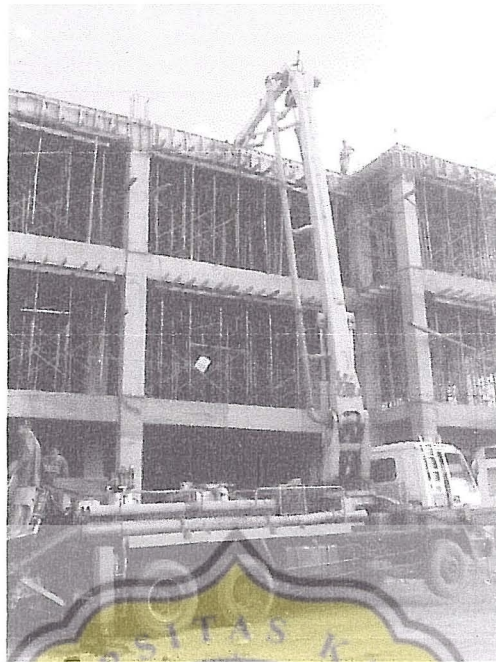
Gambar 4.14 Concrete Pump (Sumber: Dokumentasi Pribadi tahun 2010)
