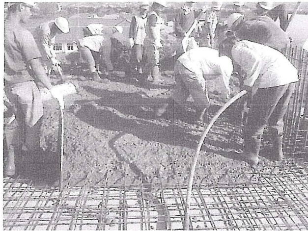
Gambar 5.25 Pengecoran balok dan plat lantai (Sumber: Dokumentasi Pribadi tahun 2010)
