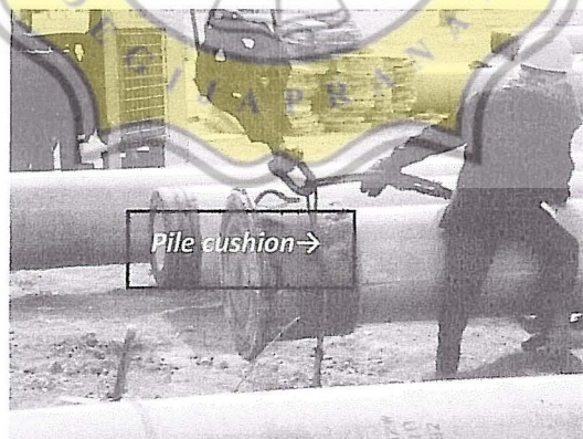
Gambar 5.3 Pemasangan pile cushion (Sumber: Dokumentasi Pribadi tahun 2010)
