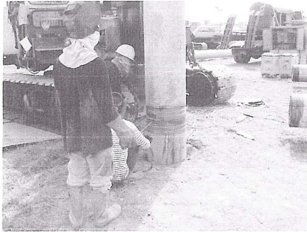
Gambar 5.5 Pengecatan Sambungan Tiang Pancang (Sumber: Dokumentasi Pribadi tahun 2010)
