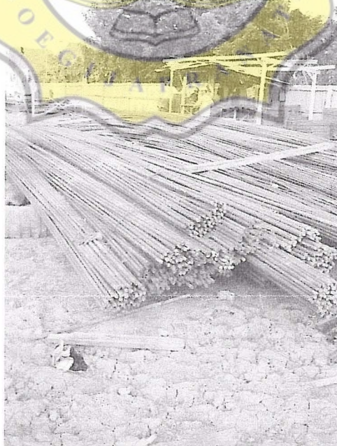
Gambar 4.3 Baja Tulangan (Sumber: Dokumentasi Pribadi tahun 2010)
