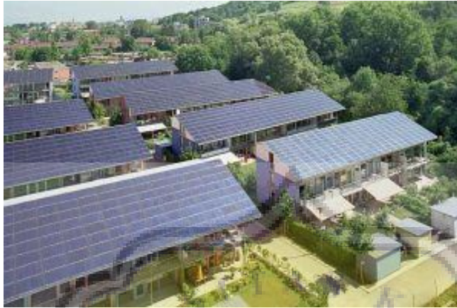
Gambar 184 Pemanfaatan tenaga surya untuk energy listrik
