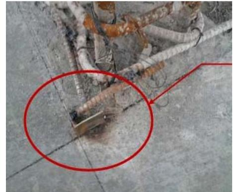
Gambar 3.40 Pembatas bekisting kolom
