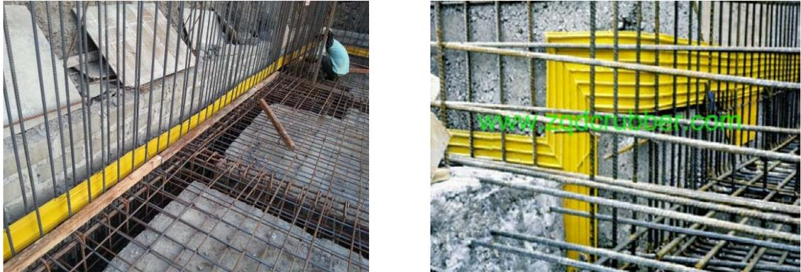
Gambar 3.35 Pemasangan Besi Stek dan PVC *Waterstop*
