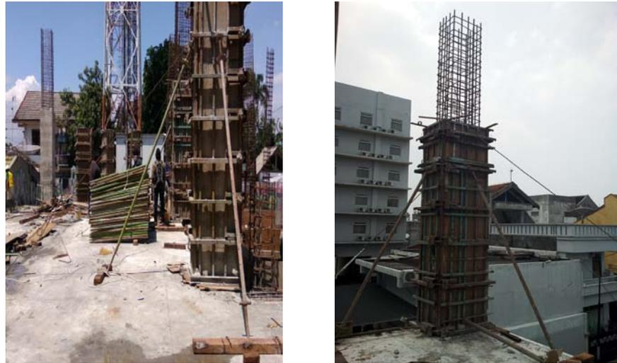
Gambar 3.44 . *Push Pull Porps* atau *Kickers Brace* bekisting kolom(Sumber: Dokumentasi Pribadi, 2016.
