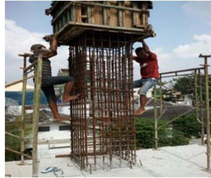
Gambar 3.87 Pekerja yang Tidak Menggunakan *Safety*
