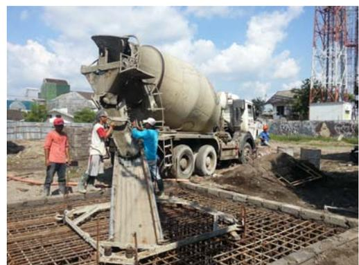
Gambar 3.6 Pengecoran Galian *Pile Cap* Untuk Pondasi *Tower Crane*
