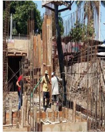
Gambar 3.28 Pengecoran *Pile Cap*
