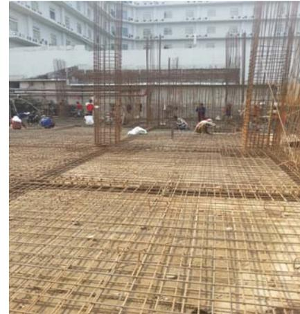
Gambar 3.25 Penulangan *Pile Cap* dan *Tie Beam*
