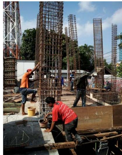
Gambar 3.42 Penyambungan Tulangan Kolom
