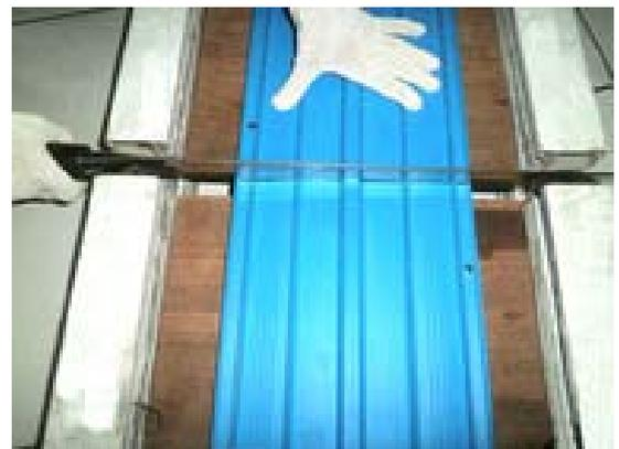
Gambar 3.34 Penyambungan PVC *Waterstop* dengan
