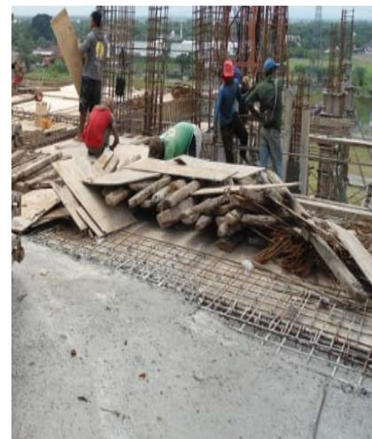
Gambar 3.49 Pembuatan Bekisting Balok
