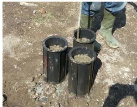
Gambar 3.81 Pengambilan Sampel Beton *Pile Cap*
