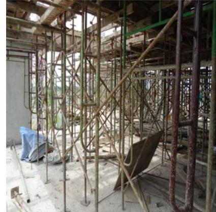
Gambar 3.48 Pemasangan Penyangga atau Perancah Balok dan Pelat Lantai
