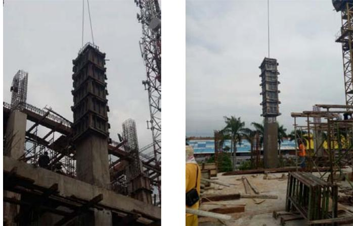
Gambar 3.47 Pelepasan Bekisting Kolom
