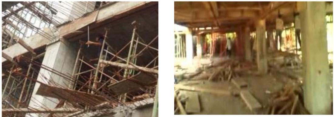
Gambar 3.57 Pelepasan Bekisting Balok dan Pelat Lantai
