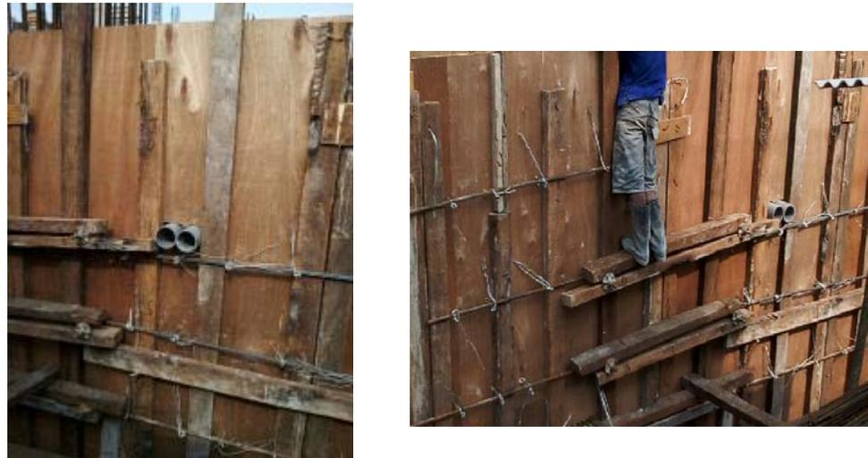
Gambar 3.36 Pemasangan Pipa PVC
