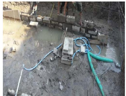
Gambar 3.26 Pembuatan Bekisting *Pile Cap*
