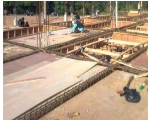
Gambar 3.52 Pembuatan Bekisting Pelat Lantai
