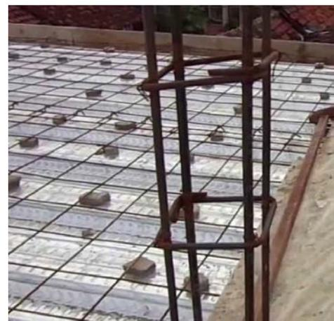
Gambar 3.51 Pemasangan Beton *Decking* Balok
