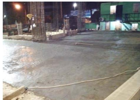
Gambar 3.29 Perawatan Beton dengan Menyiram Air
