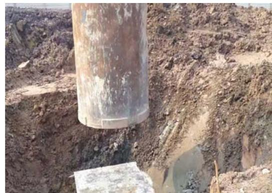
Gambar 3.20 Tinggi Jatuh *Hammer* pada PDA Test
