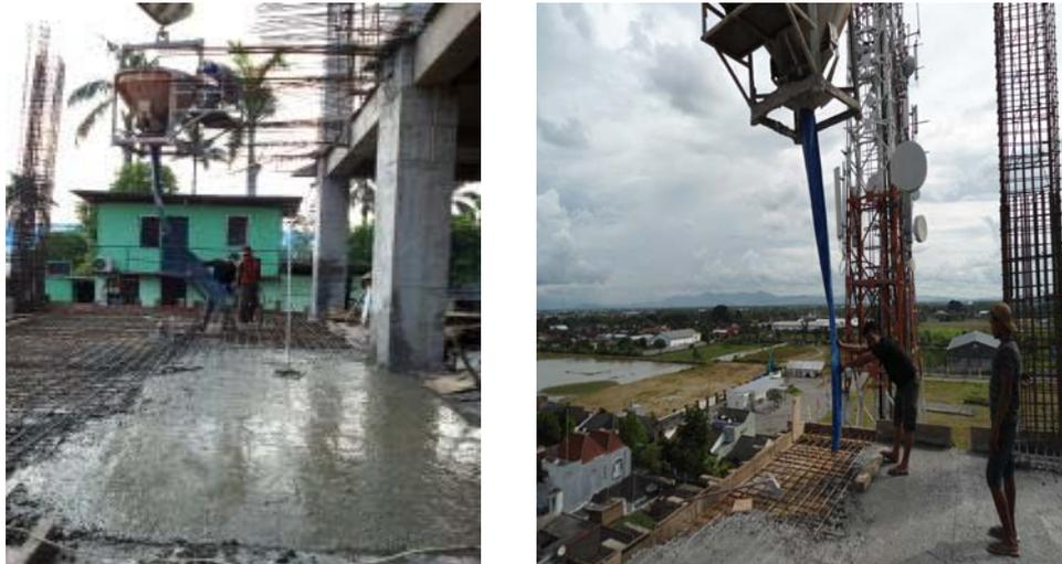
Gambar 3.55 Pengecoran Pelat Lantai dan Balok
