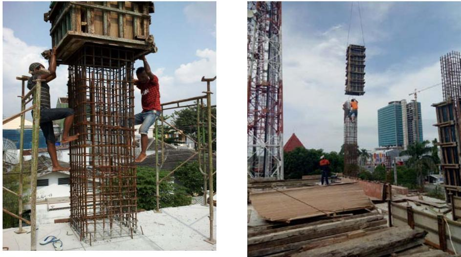
Gambar 3.43 Pemasangan Bekisting kolom
