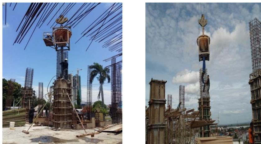
Gambar 3.45 Pengecoran Kolom Menggunakan *Bucket*
