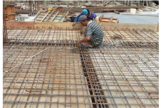
Gambar 3.27 Pengecekan Sebelum Pengecoran
