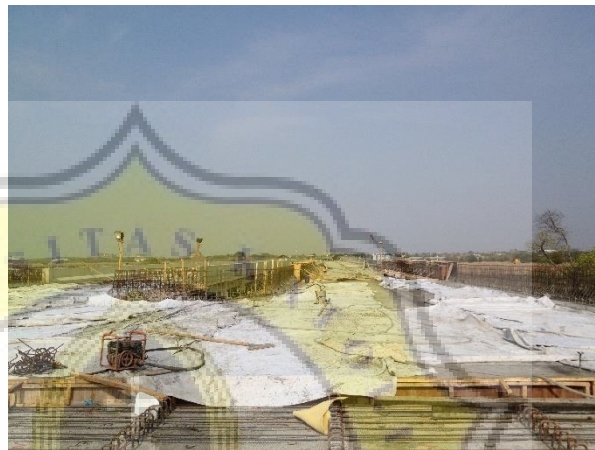
Gambar 3.25 Proses Perawatan Dengan Karpet
