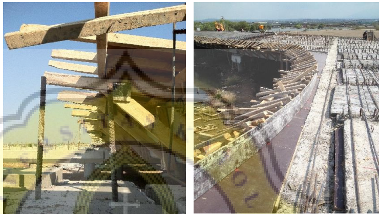
Gambar 3.17 (a) dan (b) Bekisting Kantilever Plat Slab
