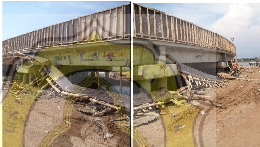
Gambar 3.27 (a) dan (b) Proses Pembongkaran Bekisting
