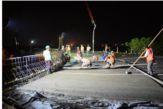
Gambar 3.23 Proses Pengecoran
