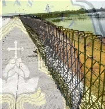
Gambar 3.16 Pembesian Pada Berrier
