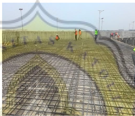
Gambar 3.11 Pembesian Pada Slab Lantai
