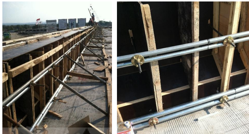
Gambar 3.19 (a) dan (b) Bekisting Berrier atau Parapet
