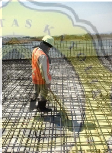
Gambar 3.20 Pembersihan Area Pengecoran
