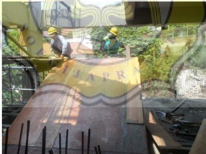
Gambar 3.18 Pemasangan Bekisting Tangga
