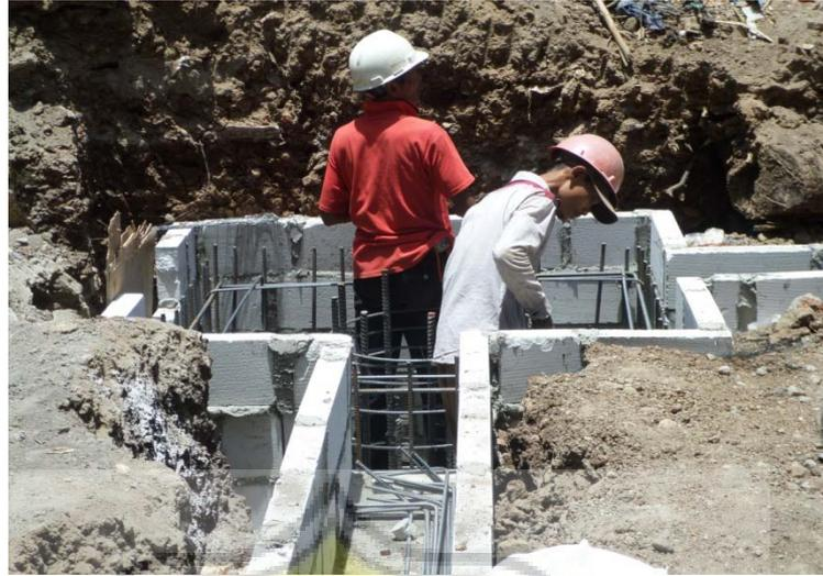
Gambar 3.2 Pemasangan Bekisting *Pilecap*
