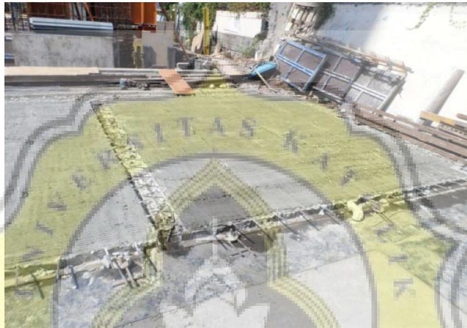
Gambar 3.17 Pengecoran Plat Lantai dengan Metode Cor Precast
