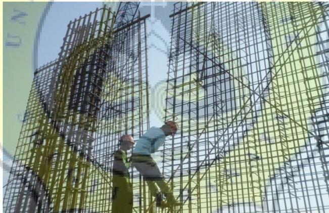
Gambar 3.21 Pemasangan Tulangan *Shearwall*
