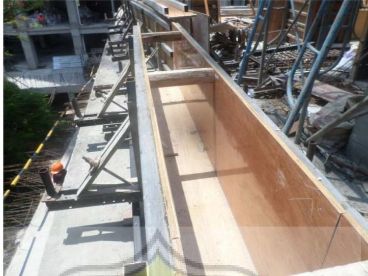
Gambar 3.11 Pembuatan Bekisting Balok
