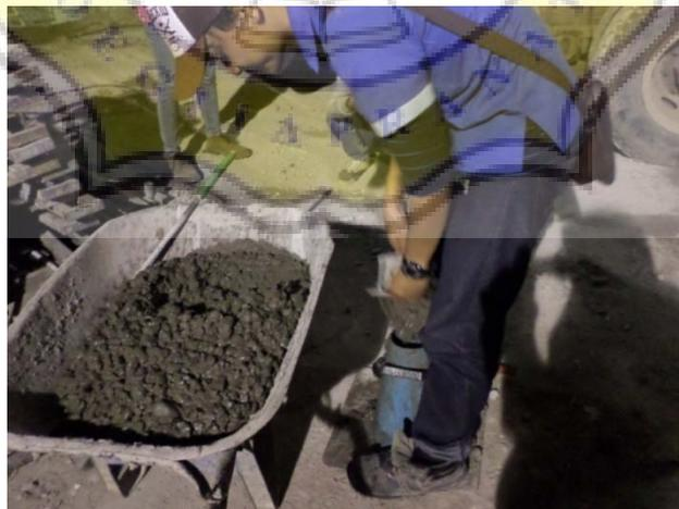
Gambar 4.5 Uji *Test Slump*
