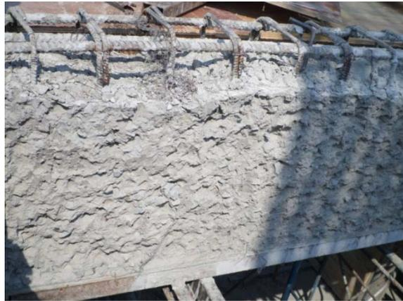
Gambar 5.4 Kesalahan teknis dalam pekerjaan pengecoran (balok kropos)
