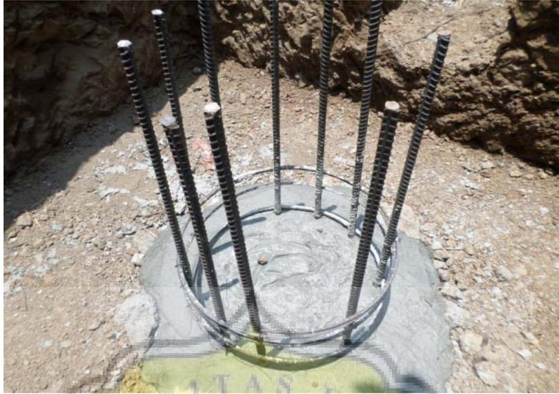
Gambar 3.1 Pengecoran Pondasi Tipe *Bored Pile*
