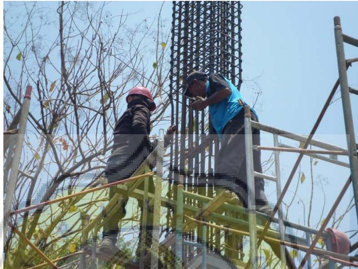
Gambar 3.6 Pemasangan Tulangan Kolom
