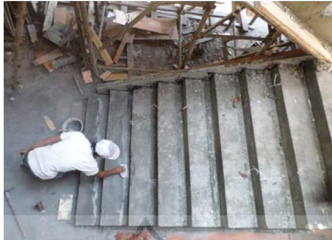
Gambar 3.20 Pengecoran Tangga Dengan Metode Konvensional
