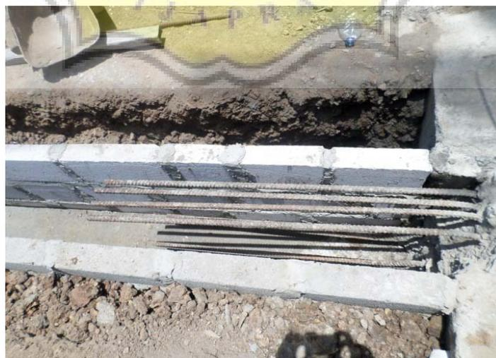
Gambar 3.5 Pemasangan Tulangan *Tiebeam*
