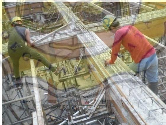
Gambar 5.5 Perbaikan balok saat setelah pengecoran
