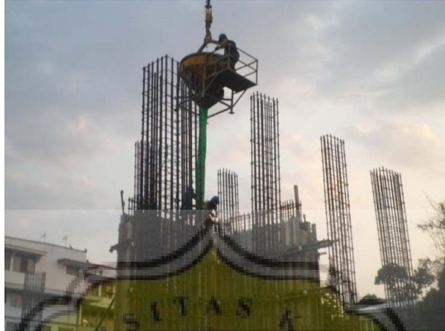
Gambar 3.24 Pengecoran *Shearwall* dengan Pipa Tremi
