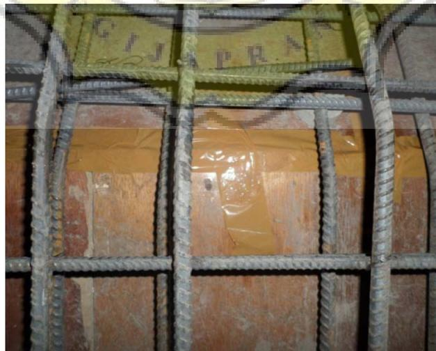
Gambar 5.3 Kesalahan teknis dalam pekerjaan bekisting (bekisting tidak rapat)
