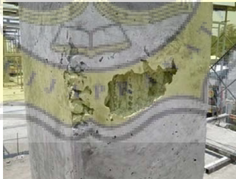
Gambar 3.80. Beton Berongga (Sumber: dokumentasi pribadi, 2015)
