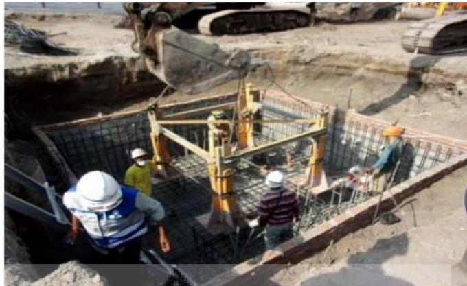
**Gambar 3.7** Instal Pembesian *Pile Cap*
