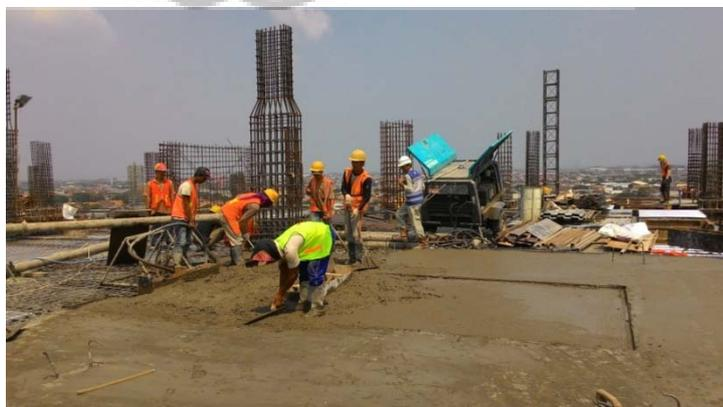
**Gambar 3.43** Proses *finishing* setelah pengecoran selesai
