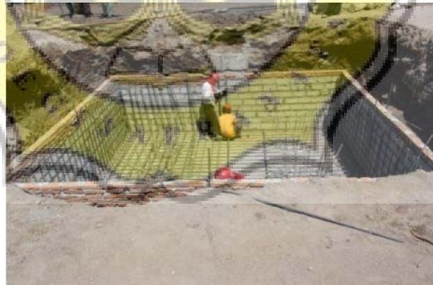
**Gambar 3.6** Membuat Lantai Kerja dan Pemasangan Batako / Batu Bata
