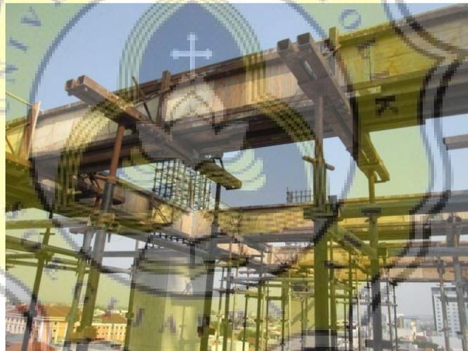
**Gambar 3.63** Bekisting kolom (atas) dan balok (bawah) yang digunakan
