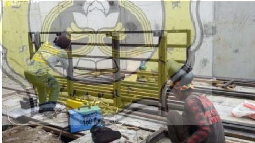
**Gambar 3.20** Fabrikasi bekisting kolom
