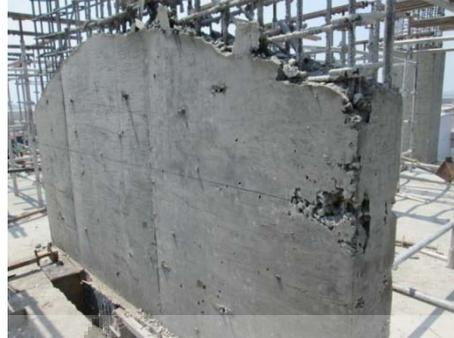
**Gambar 3.94** *Shear Wall* yang masih keropos ketika bekisting dilepas
