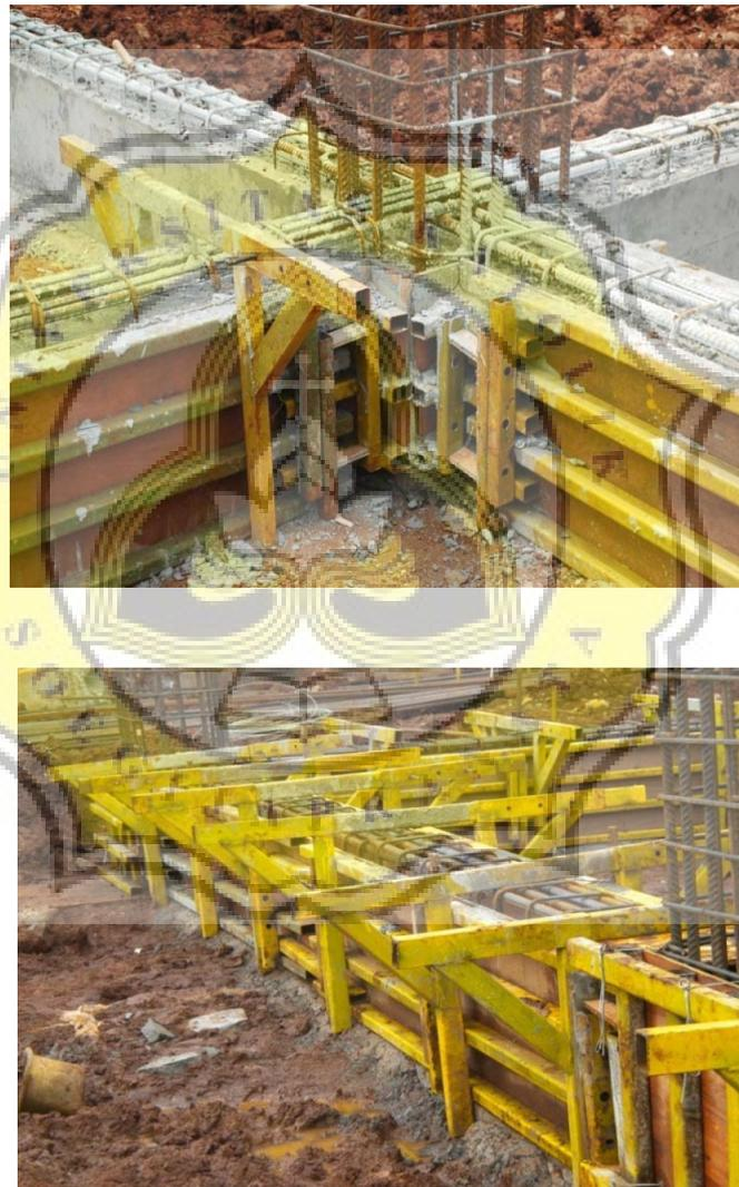
**Gambar 3.9** Proses Penulangan dan Pemasangan Bekisting *Tie Beam*
