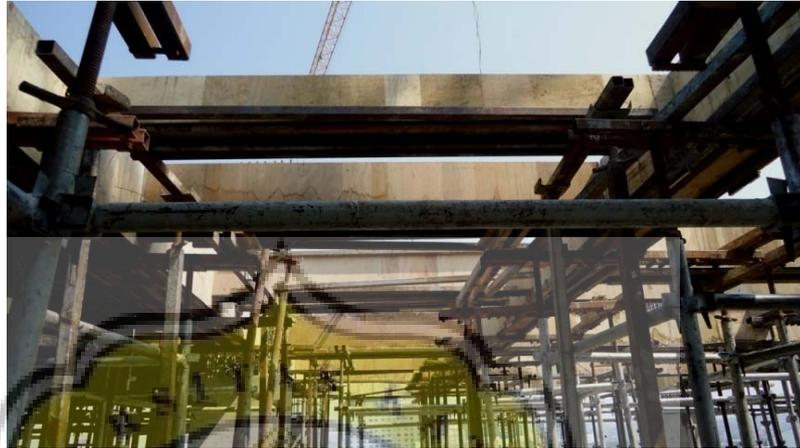
**Gambar 3.33** Bekisting balok yang sudah terpasang
