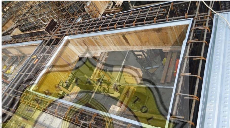
**Gambar 3.35** Lubang pelat untuk bekisting dengan material *steel deck*
