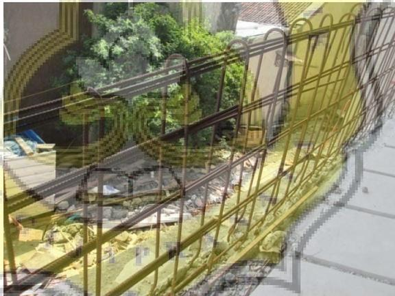
**Gambar 3.50** Tulangan dinding parapet yang telah terpasang
