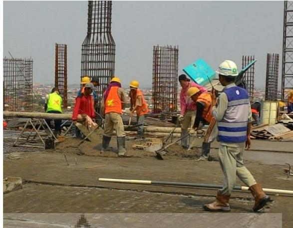
**Gambar 3.41** *Ready mix* yang keluar dari pipa baja
