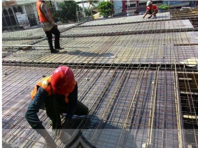
**Gambar 3.38** Proses pemasangan *wiremesh* M8-150
