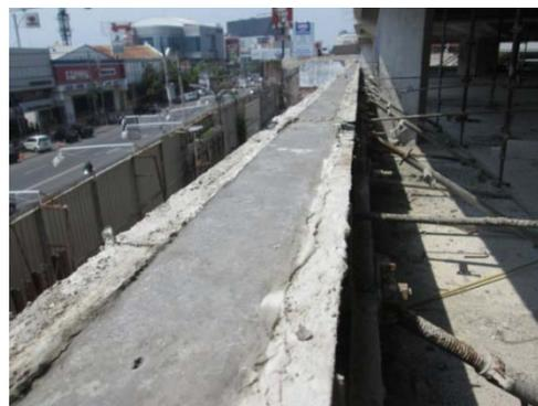
**Gambar 3.52** Dinding parapet yang telah selesai dicor (tampak atas)
