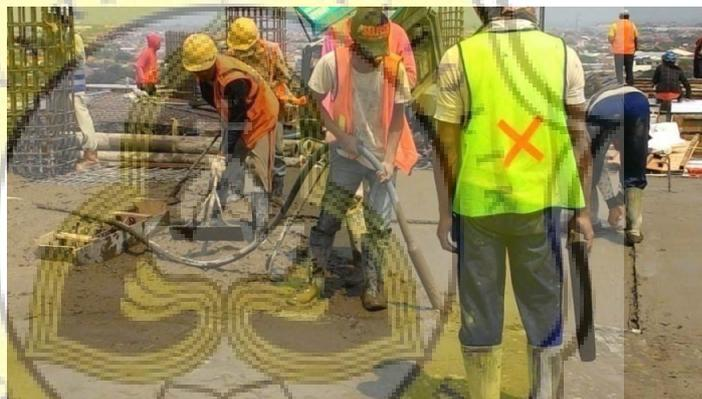
**Gambar 3.42** Beton *ready mix* dengan penggaruk dan dipadatkan dengan menggunakan *concrete vibrator*
