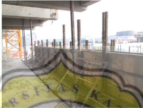
**Gambar 3.51** Bekisting dinding parapet yang sudah terpasang dan siap dicor
