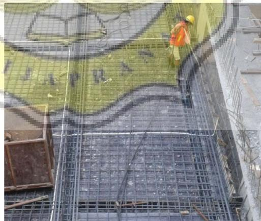
**Gambar 3.40** Pembersihan area yang akan dicor menggunakan *air compressor*
