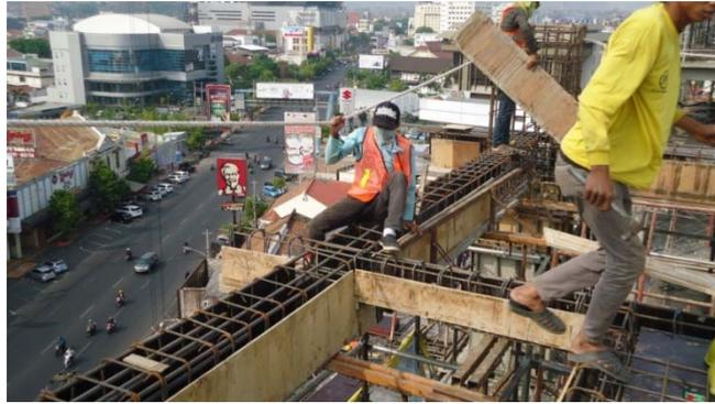
**Gambar 3.92** Pekerja bagian pembesian yang tidak memakai *body harness* dan helm pada saat melakukan pekerjaan pembesian di pinggir gedung Lt.9
