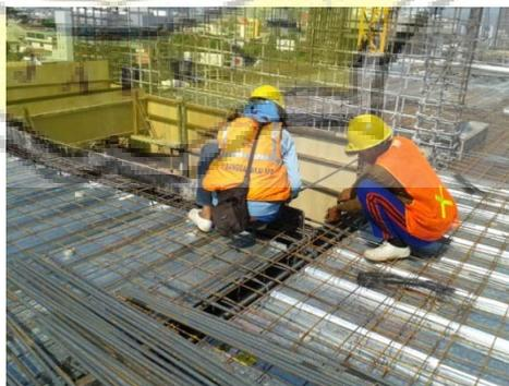
**Gambar 3.37** Proses penulangan pada balok
