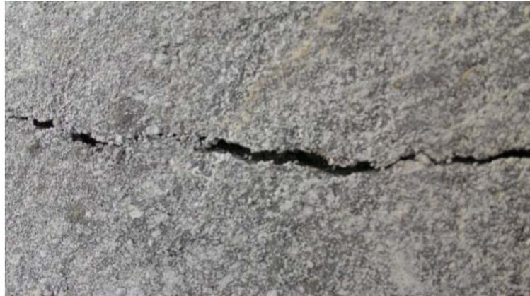
**Gambar 3.95** Retak struktur pada pelat lantai
