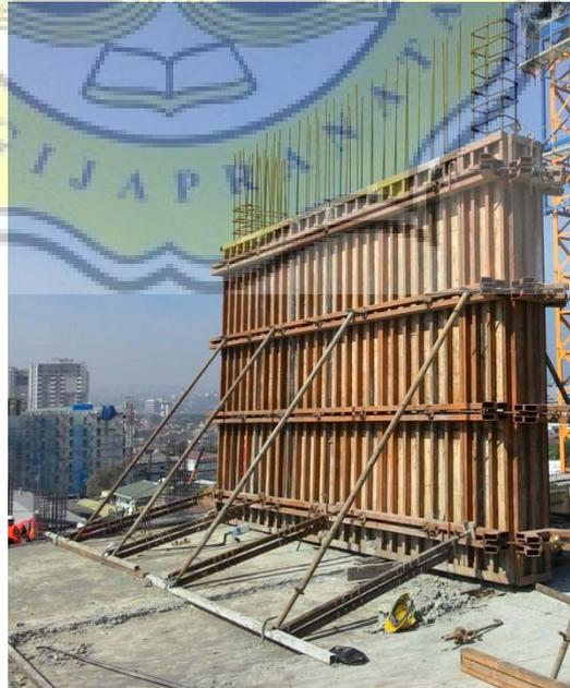
**Gambar 3.28** Bekisting *Shear Wall* yang sudah terpasang
