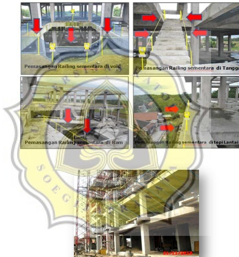
**Gambar 3.90** Railing pengaman dan *Safety net*
