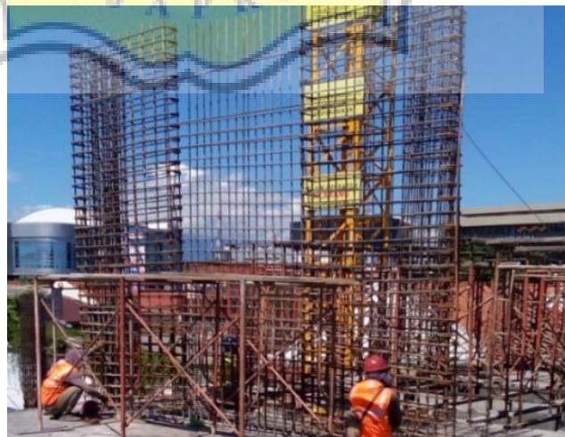
**Gambar 3.27** Penulangan *Shear Wall*
