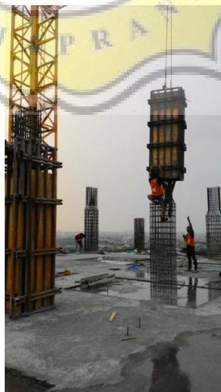
**Gambar 3.23** Proses pemasangan bekisting kolom
