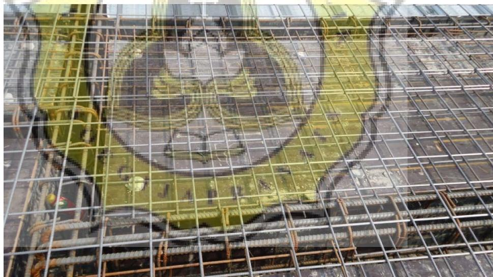
**Gambar 3.39** *Wiremesh* M8-150 yang sudah terpasang pada pelat lantai
