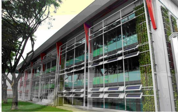
Gambar 5.5 Bagian sisi barat dipasang kaca-kaca low emissivity yang beriteriskan panel surya Sumber: C.E.Mediastika,2013:318
