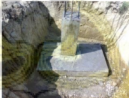
Gambar 4.4. Pondasi foot plat Sumber: kampuzsipil.blogspot.com
