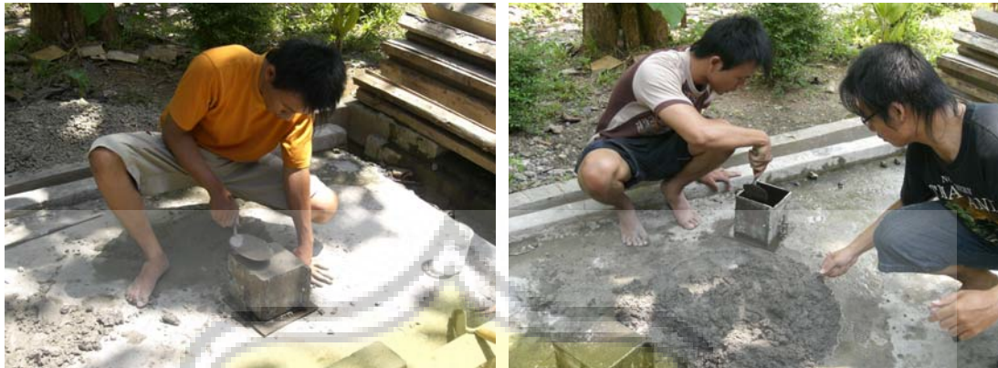
Proses pembuatan benda uji kubus beton (Sumber: dokumentasi pribadi)
