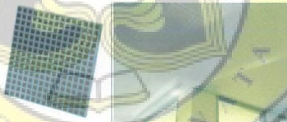
Gambar III.48 (kiri) Satuan *Grid Absorber* dan (kanan) Hasil Pemasangan *Grid Absorber* pada Ceiling
