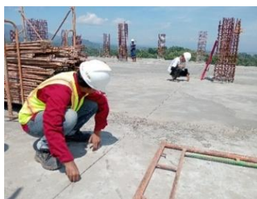
Gambar 5.3 Proses Penandaan yang dilakukan dari Garis Bantu
