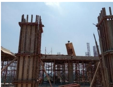
Gambar 3.37 Proses Pemasangan Bekisting
