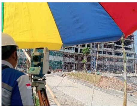
Gambar 3.2 Penggunaan Total Stations pada Proyek
