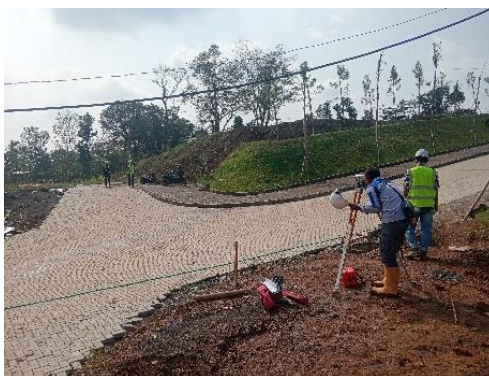
Gambar 3.3 Penggunaan Waterpass pada Proyek
