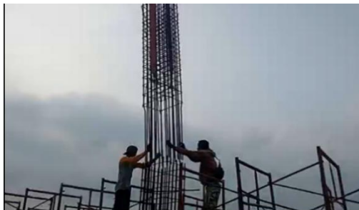
Gambar 3.36 Proses Penyambungan Tulangan Kolom
