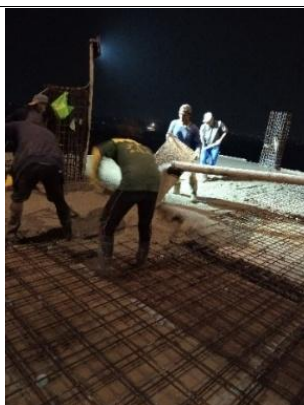
Gambar 5.14 Proses Pengecoran Pelat dan Balok
