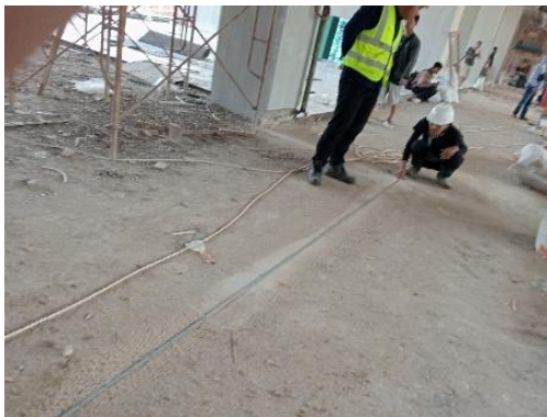
Gambar 5.8 Proses Penandaan Lantai untuk Pemasangan Keramik
