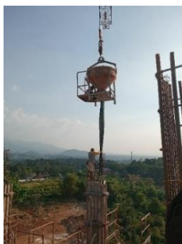
Gambar 3.38 Proses Pengecoran Kolom
