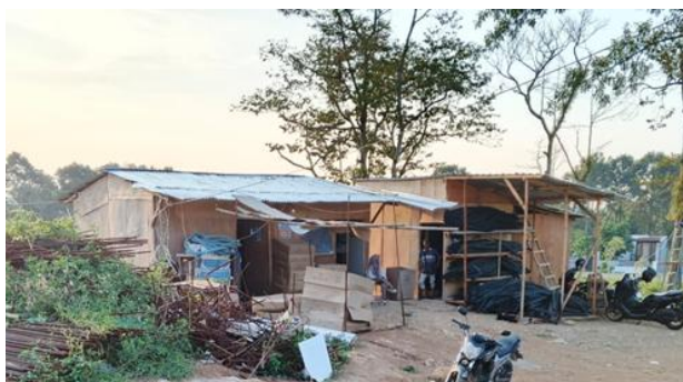
Gambar 3.29 Bangunan Logistik (Sumber: Dokumen PT. SCCR Indonesia)
