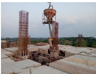
Gambar 5.15 Proses Pengecoran Kolom
