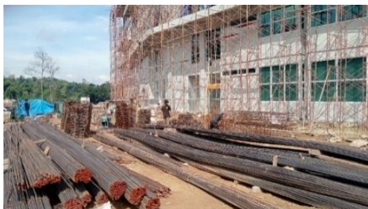
Gambar 3.32 Pabrikasi Alat (Sumber: Dokumen PT. SCCR Indonesia)
