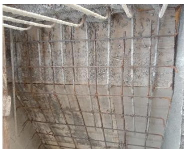
Gambar 3.44 Pembuatan Tulangan Tangga
