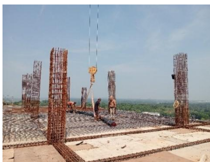
Gambar 3.42 Pembuatan Tulangan Plat Lantai
