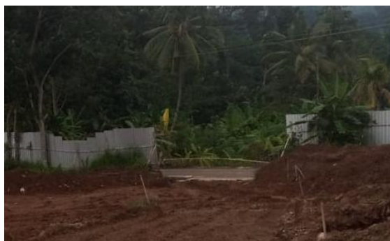
Gambar 3.25 Pemagaran di Proyek (Sumber: Dokumen PT. SCCR Indonesia)
