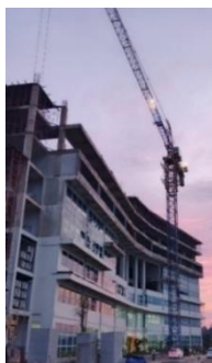
Gambar 4.6 Kondisi Tower Crane di Proyek
