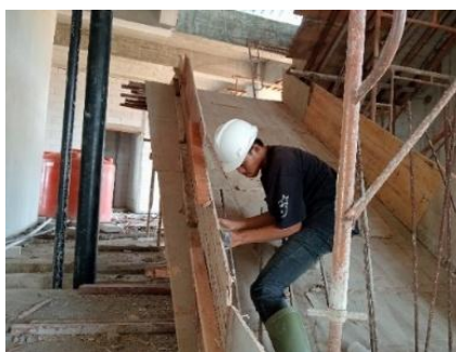
Gambar 3.43 Pembuatan Bekisting Tangga
