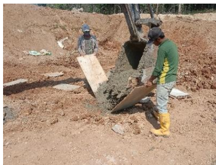
Gambar 3.33 Fondasi Bored Pile (Sumber: Dokumen PT SCCR Indonesia)
