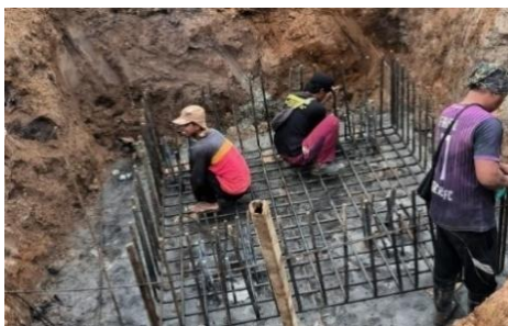
Gambar 3.34 Penulangan Pile Cap (Sumber: Dokumen PT SCCR Indonesia)
