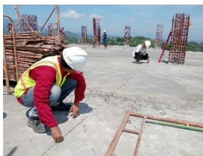
Gambar 3.35 Proses Penandaan Kolom
