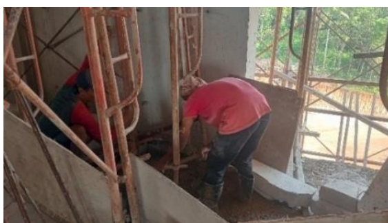
Gambar 3.46 Pengecoran Tangga
