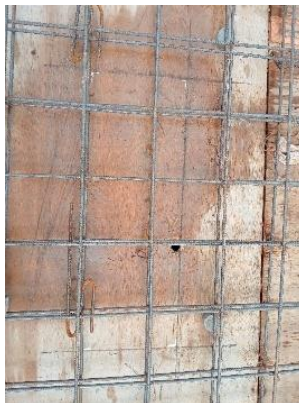
Gambar 5.10 Hasil Pembuatan SAF Pada Jalur Instalasi MEP
