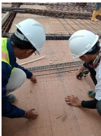
Gambar 5.9 Pembuatan SAF Pada Jalur Instalasi MEP
