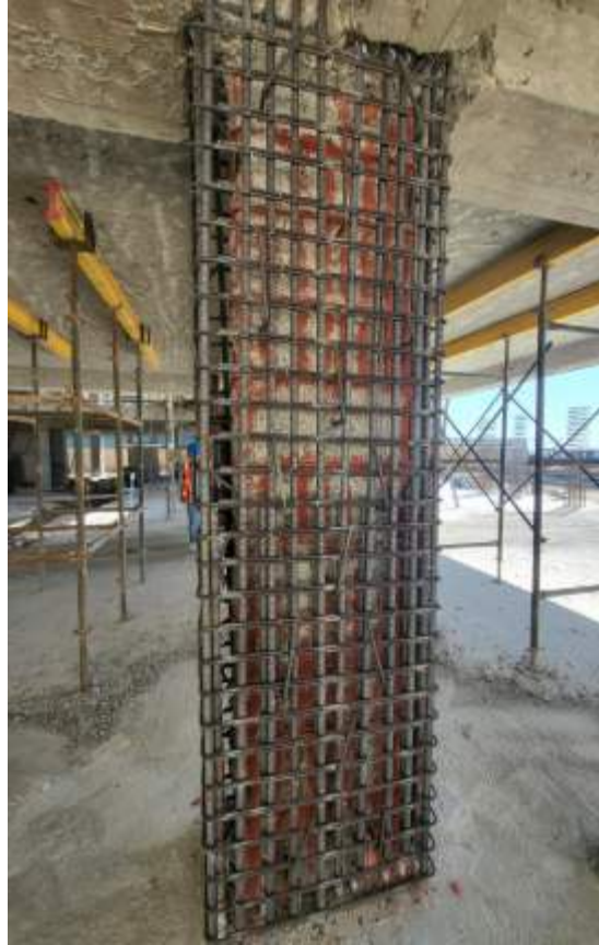
Gambar 5.1. Jacketing pada kolom
