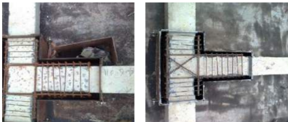
Gambar 5.2. Jacketing pada balok hingga joint Kolom-Balok
