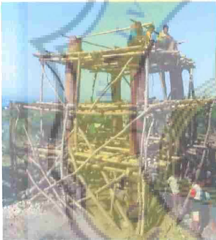
Rangka yang digunakan untuk pijakan memanjat keatas Pongga
