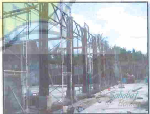
Gambar 4.3 Gambar Struktur Rangka Bambu
