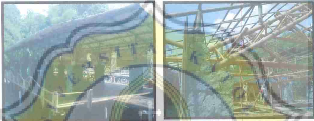
Gambar 4.8 Gambar Konstruksi Atap Bambu
