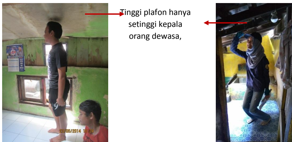
Gambar 7: Ketinggian ruang dalam setelah beberapa kali peninggian lantai
