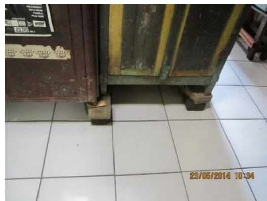
Gambar 4: Perabot diganjal dengan paving block agar tidak terendam air
