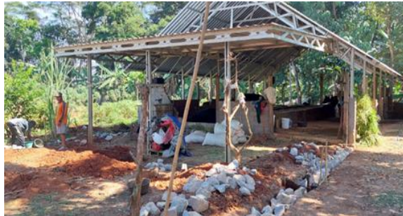
Gambar 1.3. Proses Pengerjaan Perubahan Kandang oleh Mitra Sumber: Dokumentasi Tim Kedaireka (2022)
