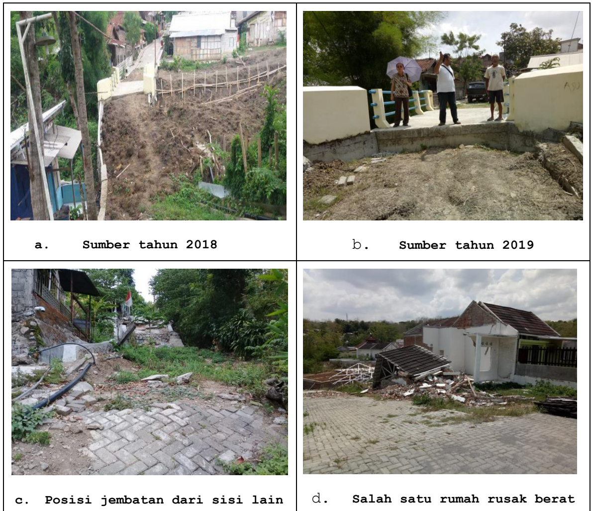
Gambar 9: Jembatan dan Rumah yang Rusak
