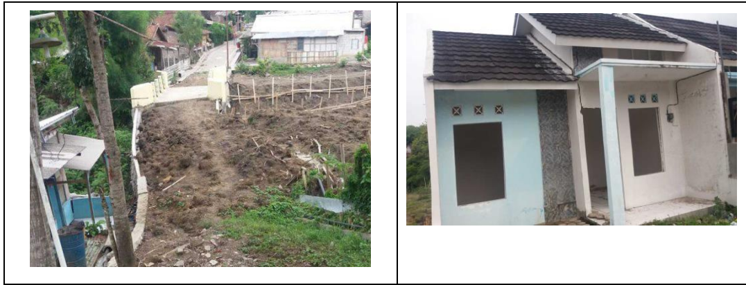
Gambar 5: Kerusakan Infrastruktur di Kampung Deliksari
