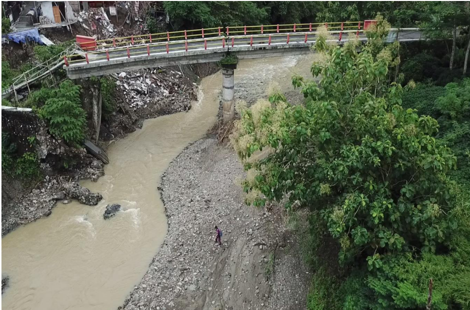
b. Kondisi Jembatan Bendosari dan Aliran Sungai Kialalang
