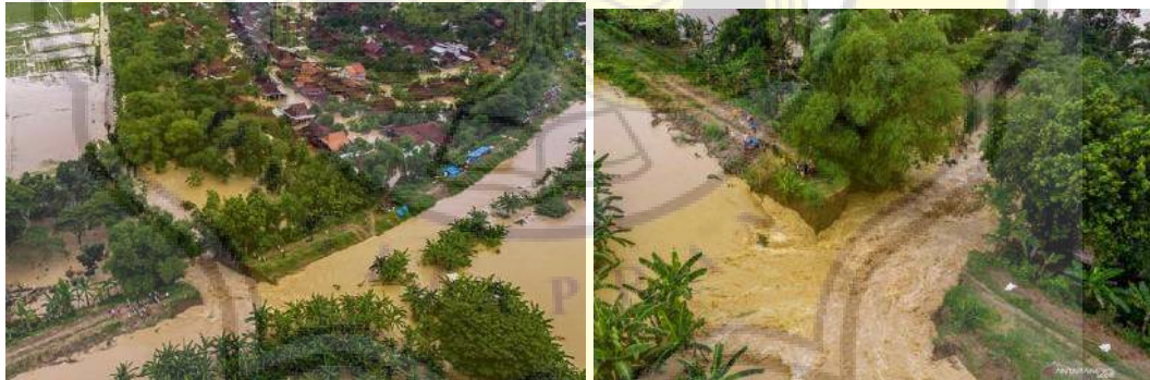
Gambar 1.1 Tanggul Sungai Tuntang di Guntur Jebol (Sumber: Dikutip dari CNN Indonesia.com diakses pada hari Rabu, 17 Agustus 2022 Pukul 14:00 WIB)
