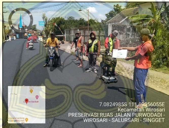
Gambar 4.2 Proyek Peningkatan Jalan Wirosari - Sulursari - Singget
