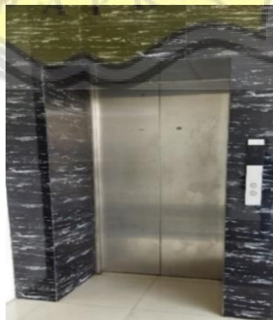
Gambar 4.55 Lift Khusus Pengguna Gedung Parkir
