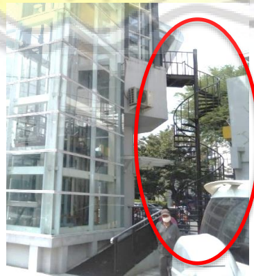
Gambar 4.57 Tangga Penghubung Jembatan Penyeberangan
