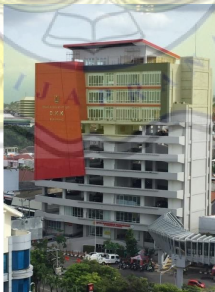
Gambar 1.2 Gedung Parkir Pandanaran (Sumber: https://twitter.com/dkksemarang diunduh pada Hari Sabtu, 25 Juni 2022, Pukul 08.59 WIB)
