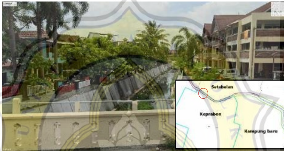
Gambar 4.21 Kondisi eksisting Sungai Pepe Kelurahan Keprabon
