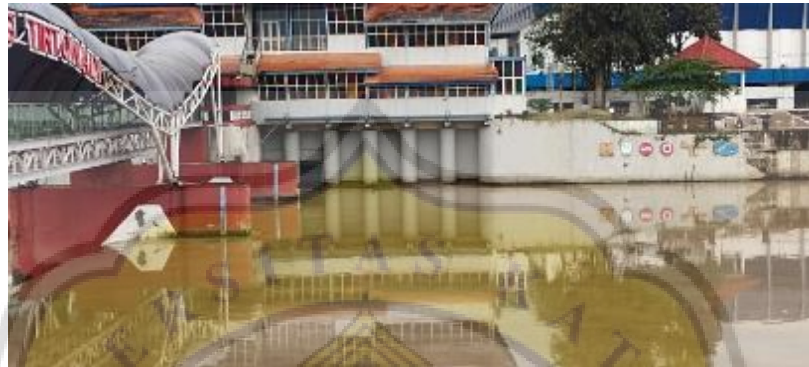
Gambar 4.41 Foto Pintu Air di Terminal Tirtonadi
