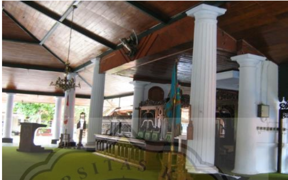
Gambar 4. 25 Kolom Pendopo Rumah Dinas Sisi Dalam (Sumber : Dokumen Survei)
