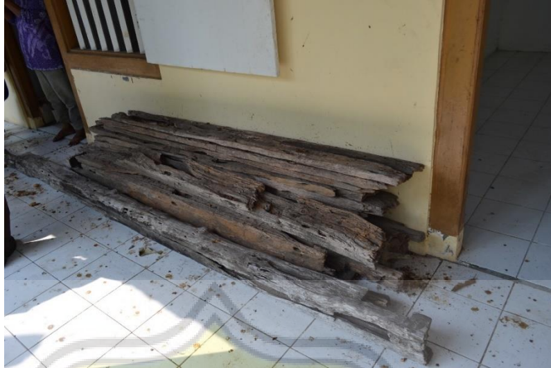
Gambar 4. 16 lantai keramik 30x30 cm pada kamar selir (Sumber: Dokumen Survei)
