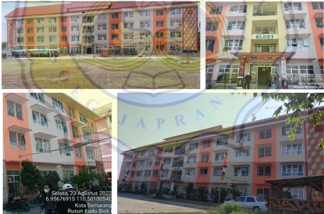
Gambar IV.9 Tampak bangunan Rusunawa Blok I (Sumber : Dokumentasi lapangan, 2022)
