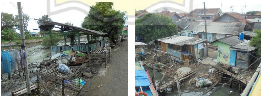
Gambar 5- 13. Bangunan Non Permanen di Badan Sungai Sumber: Hasil survei, 2022
