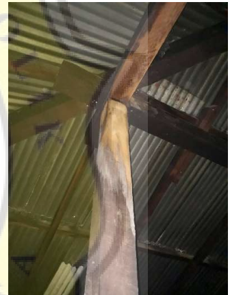
Gambar 5. 28 Konstruksi Rangka Kayu Penyangga Atap Masjid Besar Kauman Semarang Sumber: Dokumentasi Pribadi, 2022.
