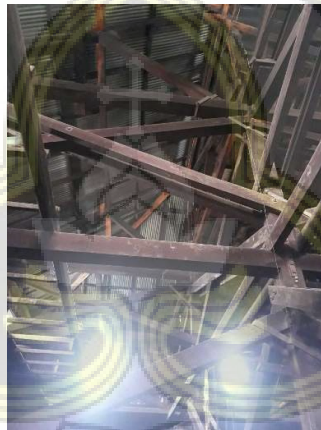
Gambar 5. 28 Konstruksi Rangka Kayu Penyangga Atap Masjid Besar Kauman Semarang Sumber: Dokumentasi Pribadi, 2022.
