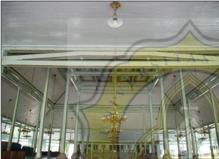
GAMBAR 4.14 Pendopo Agung Puro Mangkunegaran menggunakan 5 (lima) tiang/soko (Guru, Rowo, Emper, Goco, dan Tratag) untuk menopang 5 (lima) atap (Brunjung, Penanggap, Panitih, Paningrat, dan Tratag).
