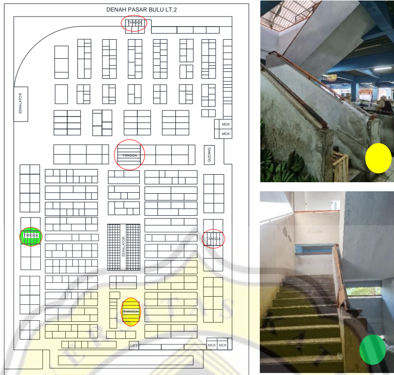
Sumber : Foto Dokumen Pribadi dan Denah Dinas Perdagangan Gambar 4.49 Tangga yang Menghubungkan Lantai 2 dan 3
