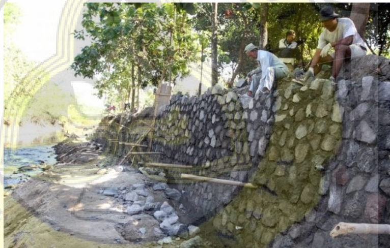
Gambar 4.9 Talud Jalan Tanjakan 2000 Air Kuning Desa Batu Merah Kecamatan Sirimau Ambon tahun 2020 Sumber: openstreetmap.id
