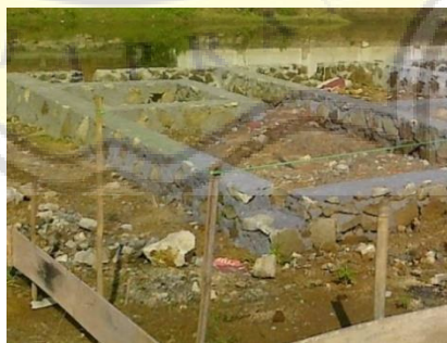
Gambar 53. Pondasi batu kali Sumber: https://arafuru.com/sipil/mengenal-pondasi-batu-kali-dan-bagian-bagian-penyusunnya.html
