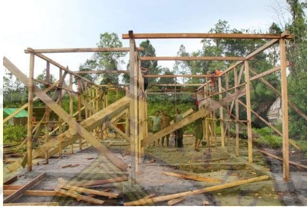
Gambar 54. Rangka bangunan kayu
