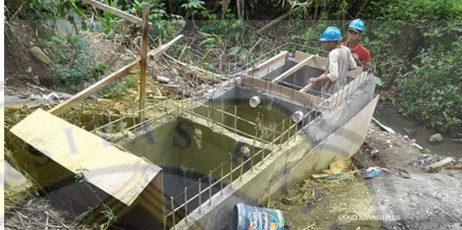
Gambar 59. Pembuatan septictank komunal Sumber: https://www.iuwashplus.or.id/arsip/4987
