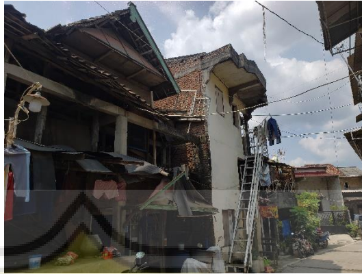
Gambar. 6 Rumah-Rumah Permukiman Warga Di Bandarharjo Sumber: Dokumentasi pribadi
