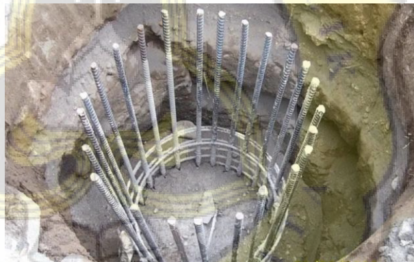
Gambar 30 gambar Konstruksi Pondasi Sumuran Sumber : Prospeku, n.d.
